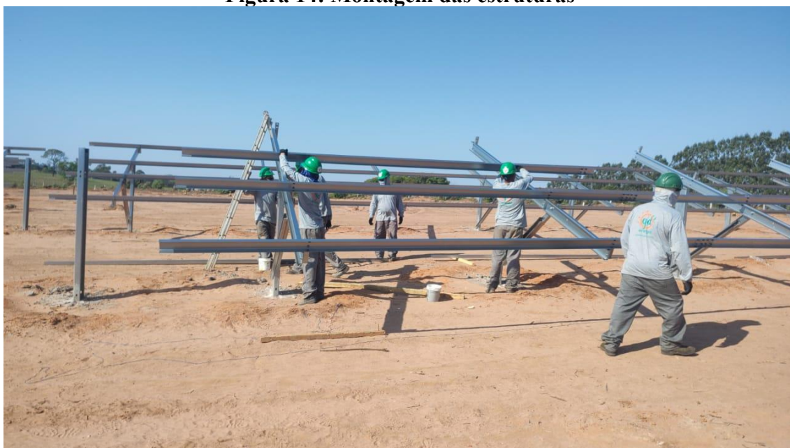
Figura 14: Montagem das estruturas
