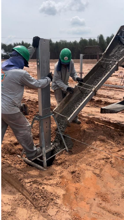
Figura 17: Concretagem das estruturas
