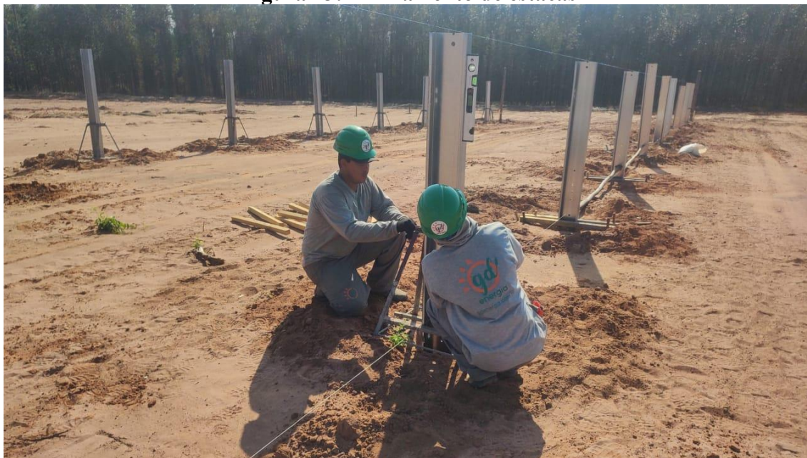
Figura 13: Alinhamento de estacas
