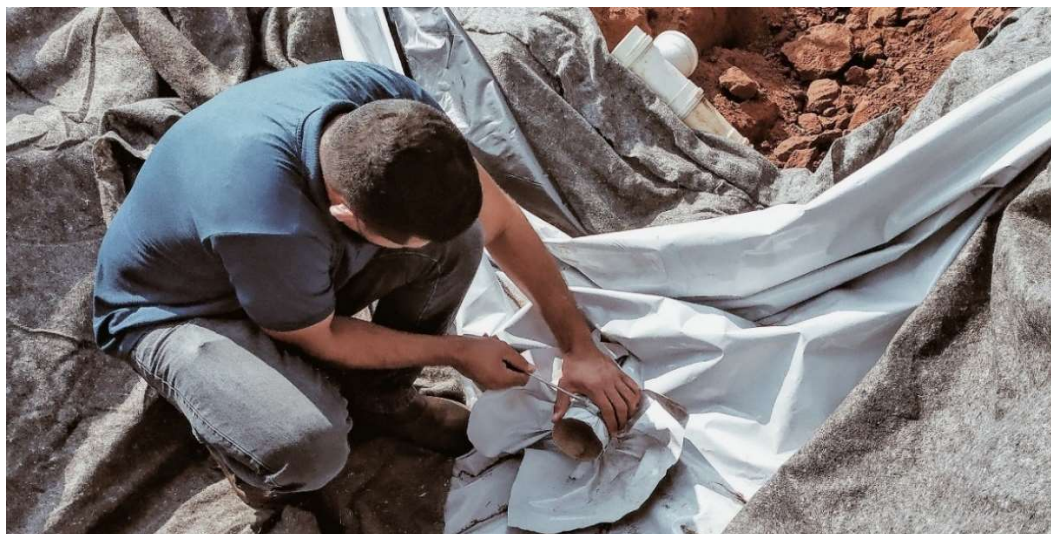
Figura 24 – Vedação da lona com abraçadeira
