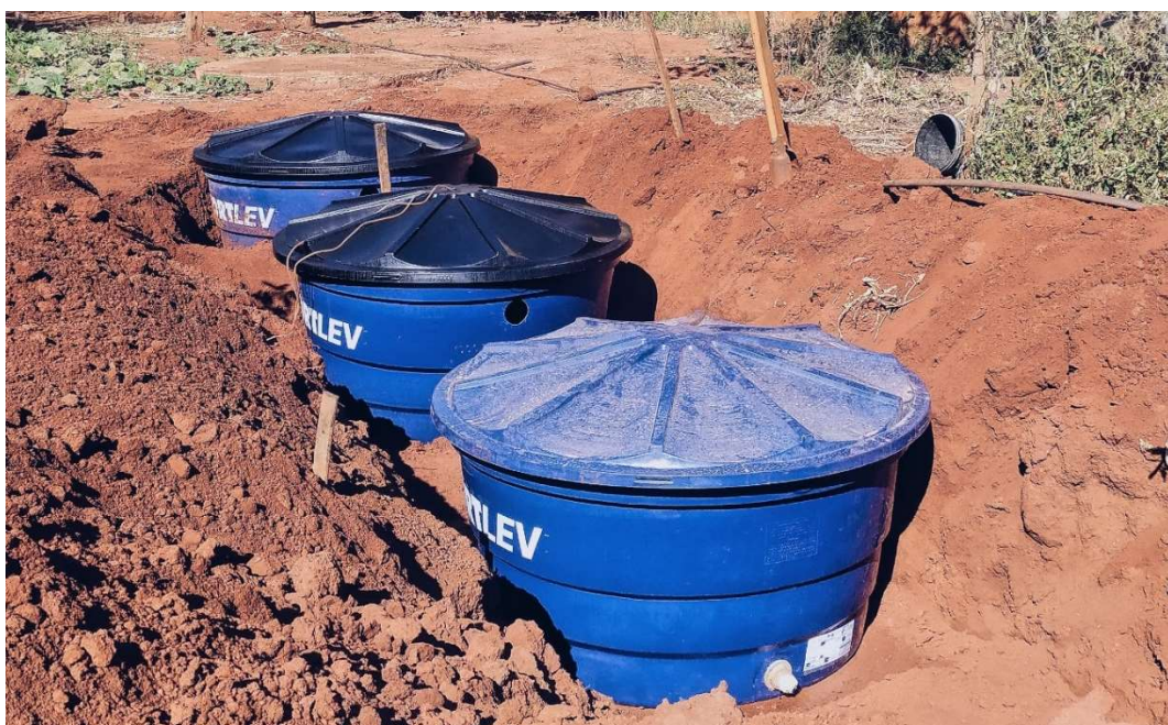
Figura 20 – Disposição das caixas na vala
