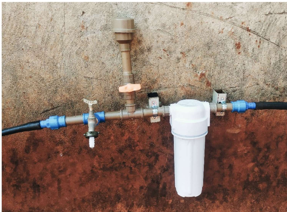
Figura 17 – Clorador adaptado com filtro de carvão
