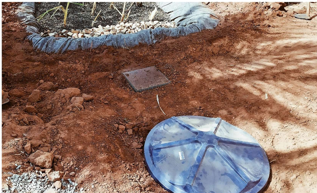
Figura 27 – Caixa de decantação e caixa de gordura
