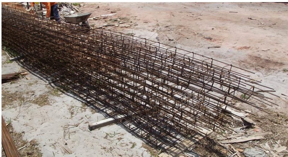
Figura 15 – Montagem e estocagem da armação
