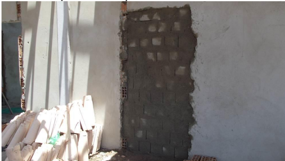
Figura 8— Alvenaria feita para substituir a porta
