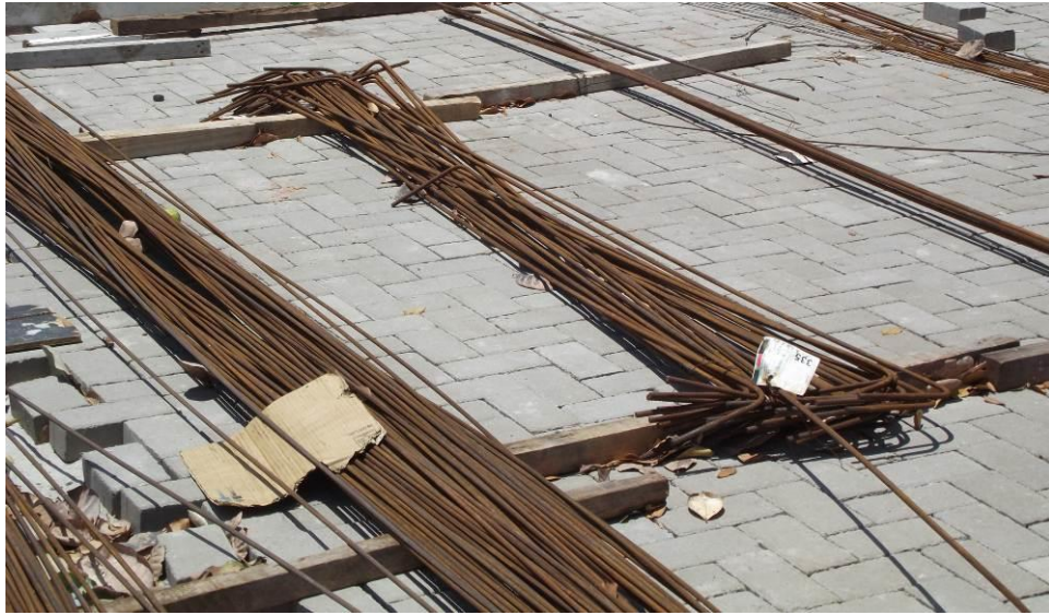
Figura 14 – Aço cortado e dobrado
