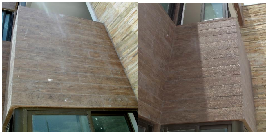
Figura 13 – Variação na aplicação do porcelanato
