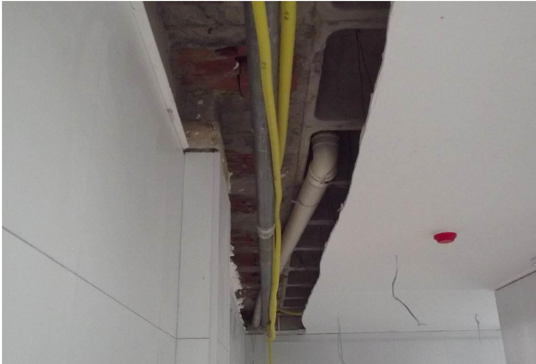
Figura 10 – Corte no forro para passagem da tubulação
