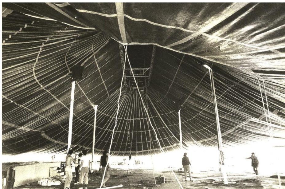
Figura 19 - Montagem da lona da Picadeiro Circo Escola.
