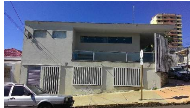
Figuras 17 e 18 - Fachada do e vista lateral do CREAS, respectivamente
