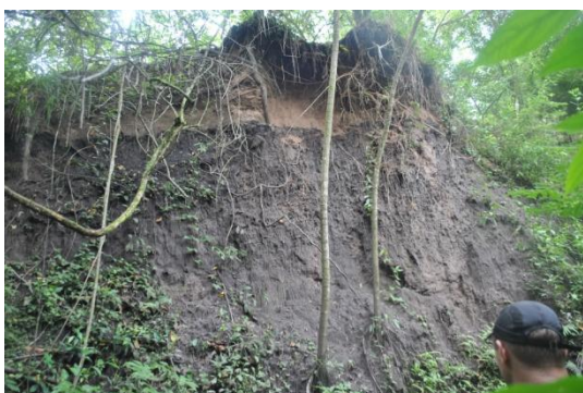
Foto 40. Margem solapadas com inclinação superior a 100%, ocasionada pela corrosão, deslizamento e desmoronamento. Foto do autor.
