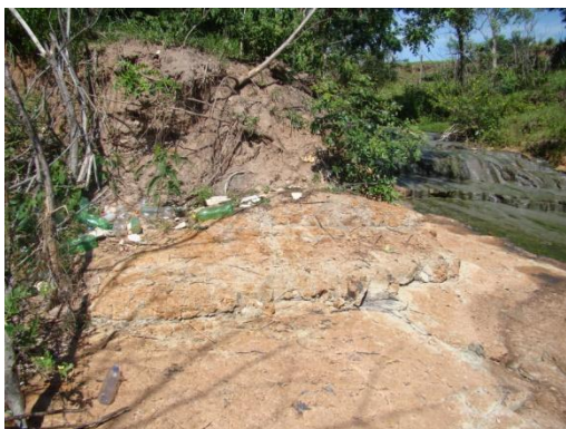
Foto 30. Leito maior com margens solapadas e depósito de lixo, canal fluvial correndo ao lado com alta carga de material orgânico. Foto do autor.
