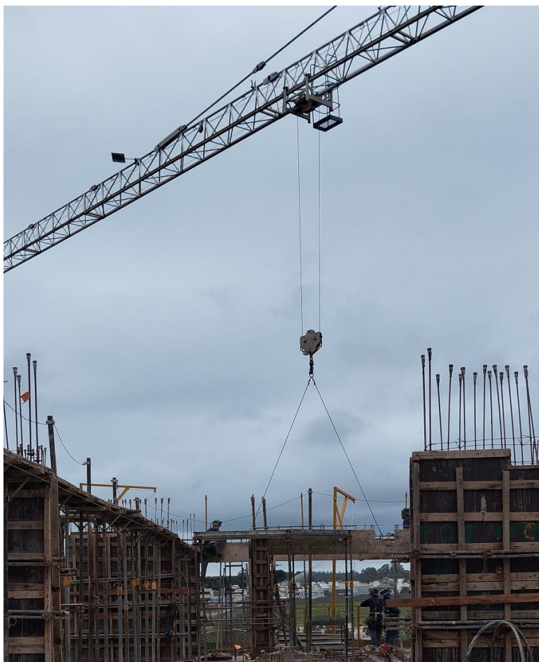
Figura 3 - Foto do içamento de uma viga pré-moldada.
