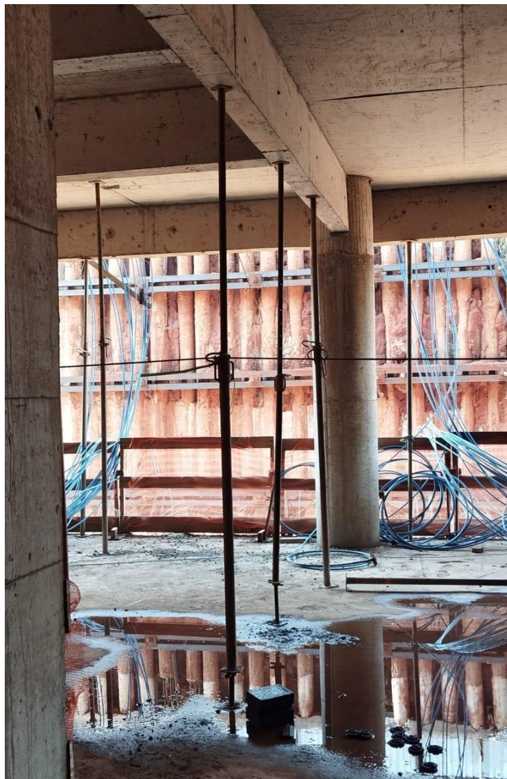
Figura 16 - Foto de escoramentos de viga (elemento sem flambagem).
