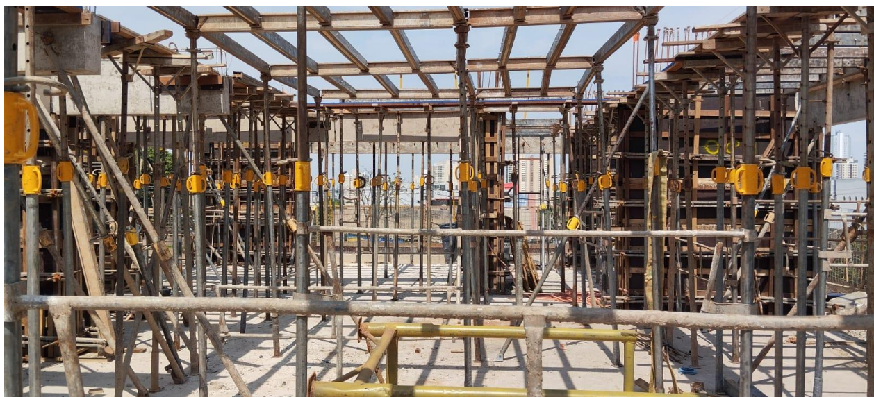
Figura 1 - Exemplo de escoramento de laje
