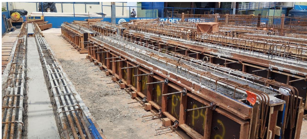
Figura 2 - Foto de fôrmas de vigas pré-moldadas
