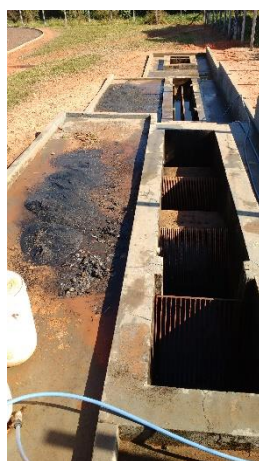
Figura 55 – Exemplo de leito de drenagem Fonte: visitas para implantação do SGA.
