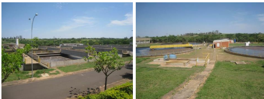
Figura 44 a e b – Tanques de aeração forçada e tanque de decantação.
