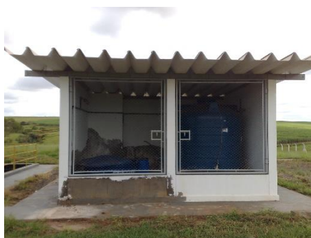
Figura 34 – Edificação para armazenamento de produtos químicos. Fonte: próprio autor.
