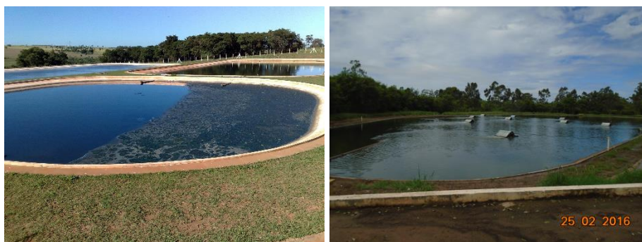
Figura 32 a e b – Vistas das lagoas existentes na RB e acúmulo de material sobrenadante. Fonte: próprio autor.
