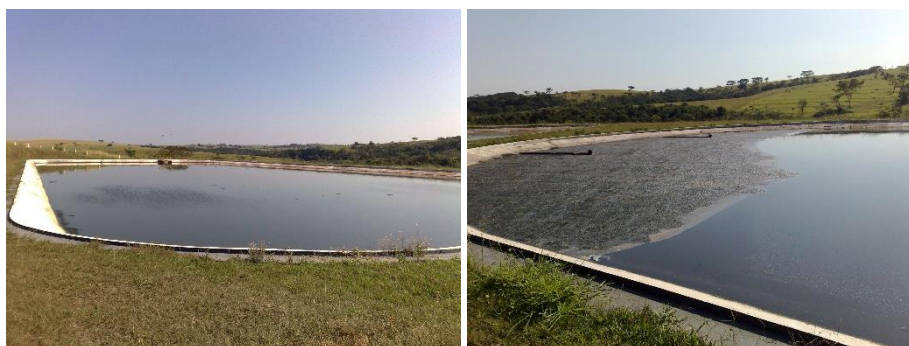
Figura 29 a e b – Vistas de lagoas existentes na RB e acúmulo de material sobrenadante. Fonte: próprio autor.
