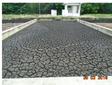
Figura 39 – Leito de secagem de lodo Fonte: próprio autor.
