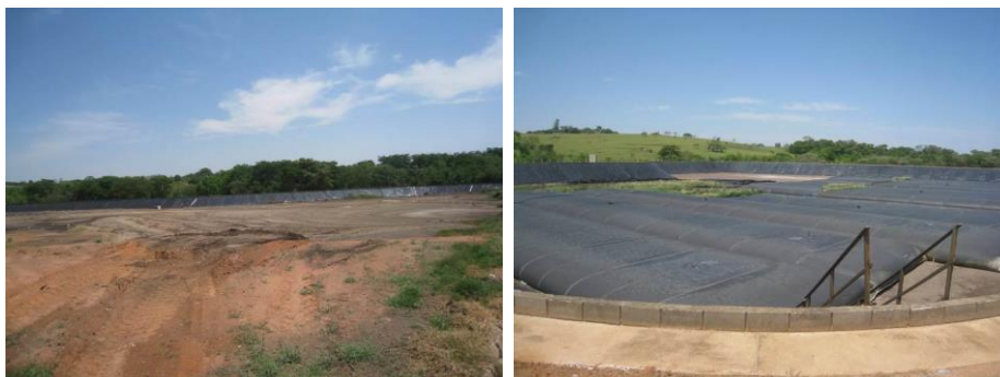
Figura 47 a e b – Células do aterro e destinação em Bag's. Fonte: próprio autor.
