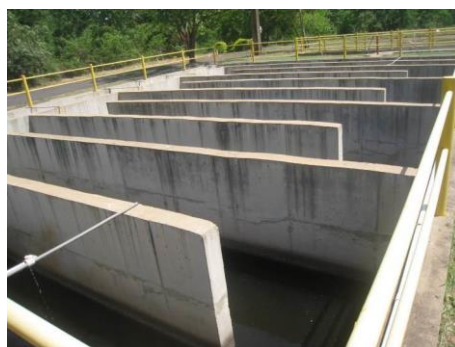
Figura 45 – Sistema de chicanas. Fonte: próprio autor.
