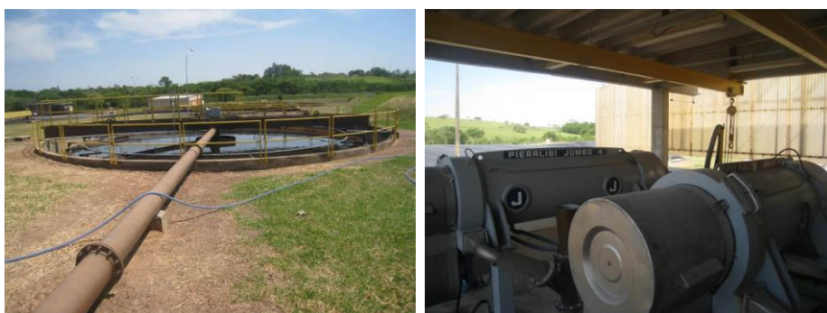
Figura 46 a e b – Adensador de lodo e centrifugas. Fonte: próprio autor.
