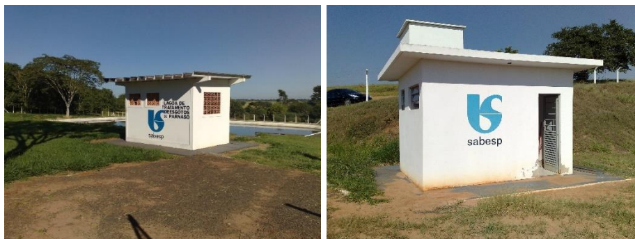
Figura 24 a e b – Padrão de edificação de apoio nas ETEs. Fonte: próprio autor.
