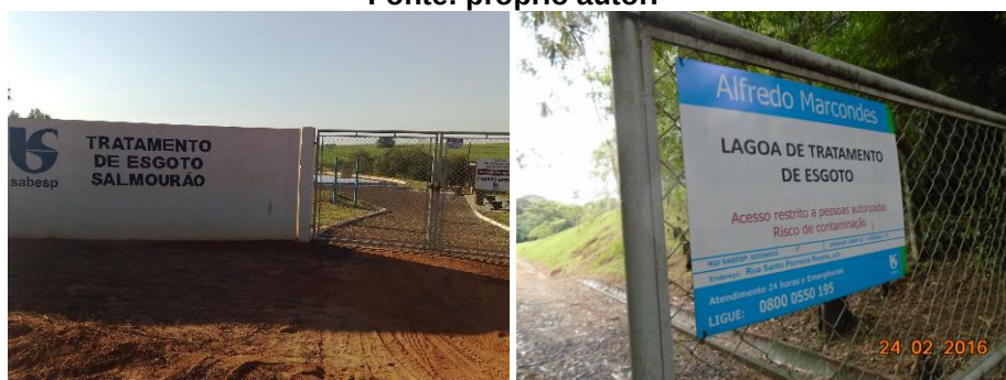
Figura 25 a e b – Identificação da ETE no portão de entrada, inclusive proibição de acesso. Fonte: próprio autor.
