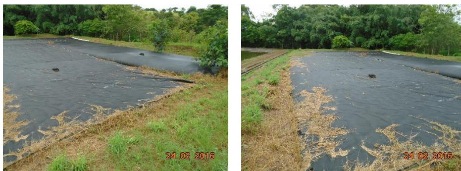
Figura 40 a e b – Big-bag cheio com lodo retirado de lagoa. Fonte: próprio autor.
