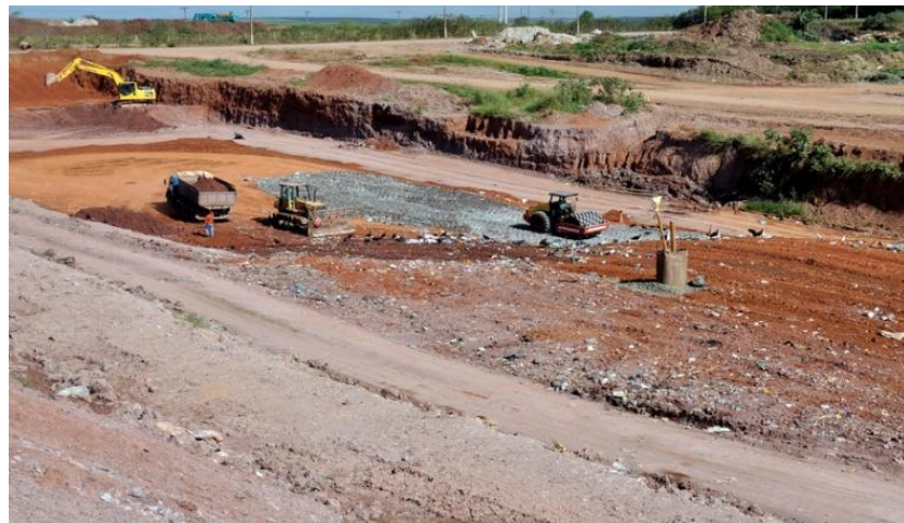
Figura 5. Aterro sanitário de Rio Claro - SP.
