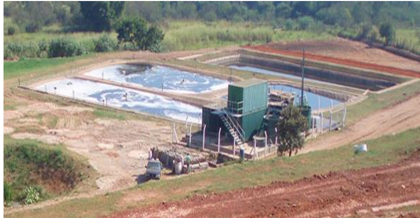
Figura 6. Estação de tratamento de Rio Claro – SP
