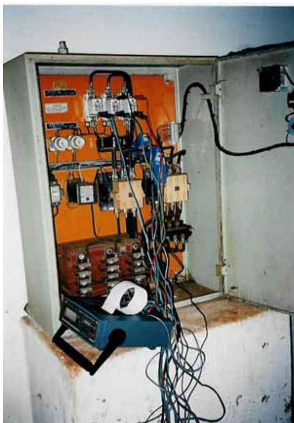
FIGURA 6. Medição do consumo de energia elétrica do poço artesiano.
