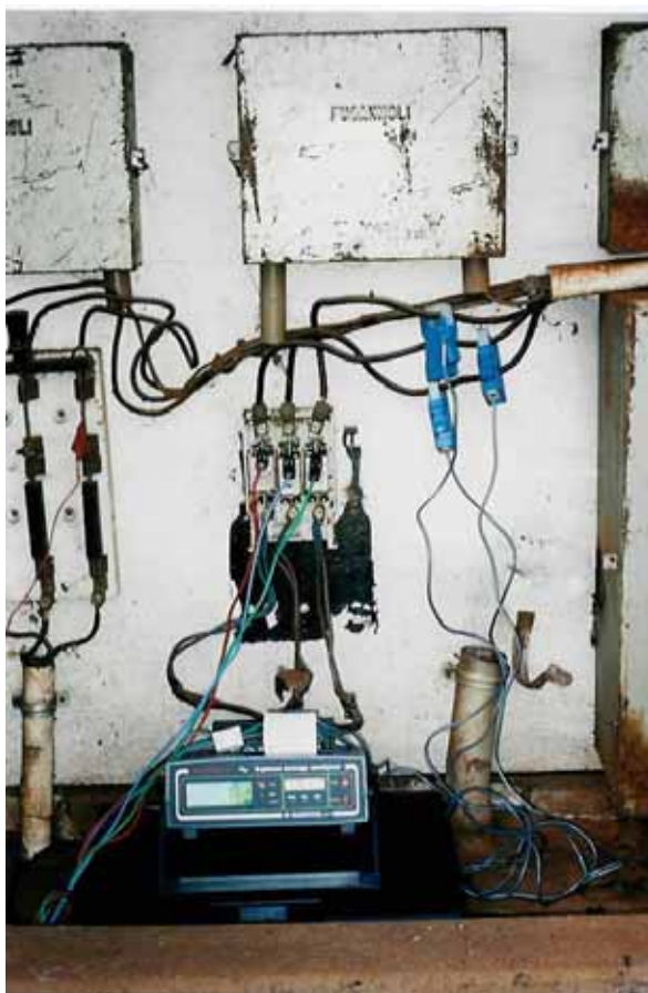
FIGURA 7. Medição do consumo de energia elétrica do motor indução trifásico de 25 CV do sistema de irrigação.
