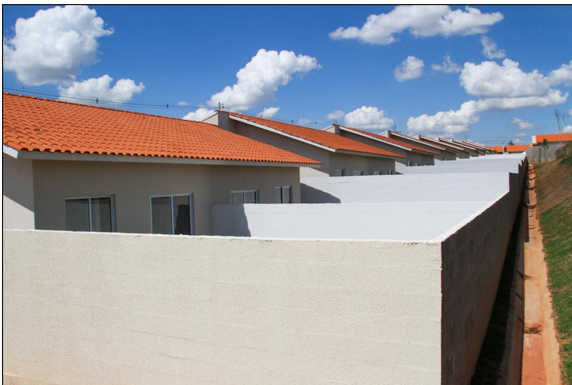
Imagem 24: Muros dos fundos das residências do Condomínio Vista do Vale, Presidente Prudente. Fonte: http://www.pdq.com.br/vale-dos-reis---res-vista-do-vale , consulta em 21/01/2014.
