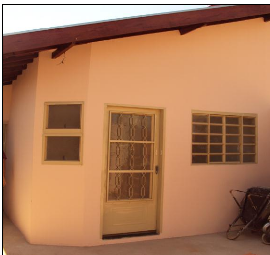
Foto 50: Casa já construída, utilizada como demonstração do material e modelos utilizados, no Cidade Aracy, em São Carlos.
