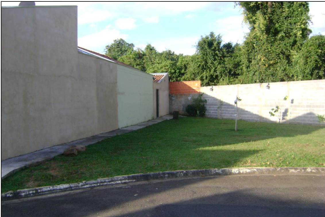
Foto 27: Muros do Condomínio Tecumseh Village, São Carlos.
