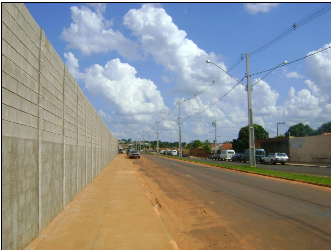
Foto 39: Muros que cercam o Condomínio Vista do Vale, Presidente Prudente.
