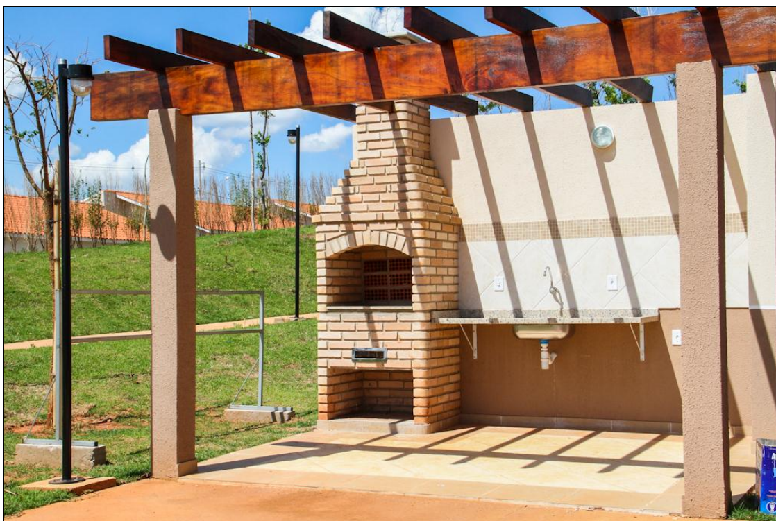
Imagem 18: Quiosque de churrasqueira finalizada com espaço reduzido, sem elementos decorativos e sombra no Condomínio Vista do Vale, Presidente Prudente.
