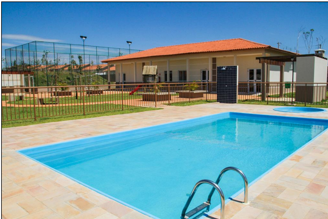
Imagem 23: Piscina finalizada, sem os elementos decorativos da propaganda no Condomínio Vista do Vale, Presidente Prudente.
