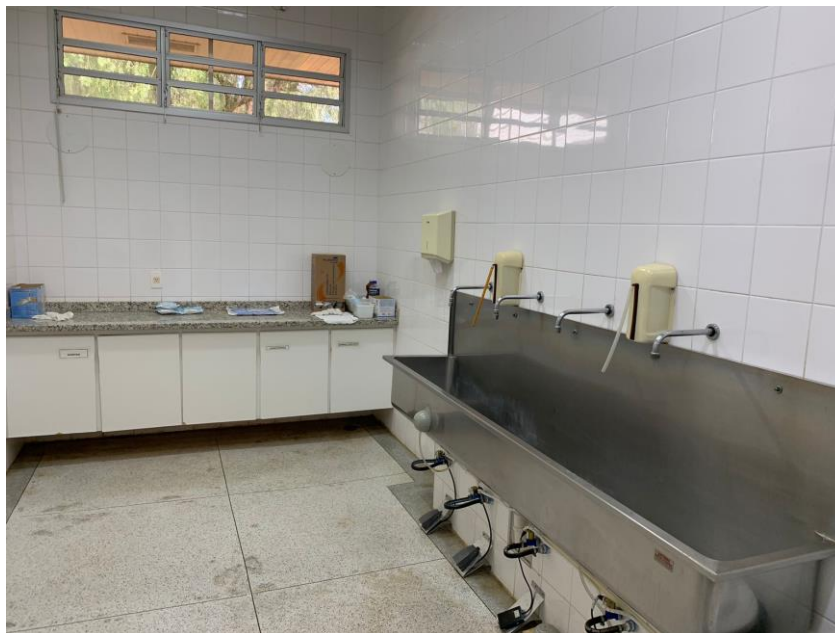
Figura 4 - Sala de paramentação do bloco cirúrgico de pequenos animais do HV-FMVA, em Araçatuba-SP.
