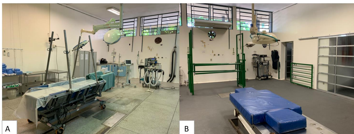
Figura 9 - Centros cirúrgicos do setor de CCGA do Hospital Veterinário da Faculdade de Medicina Veterinária e Zootecnia, em Botucatu-SP. A) Centro cirúrgico de procedimentos limpos. B) Centro cirúrgico de procedimentos contaminados.
