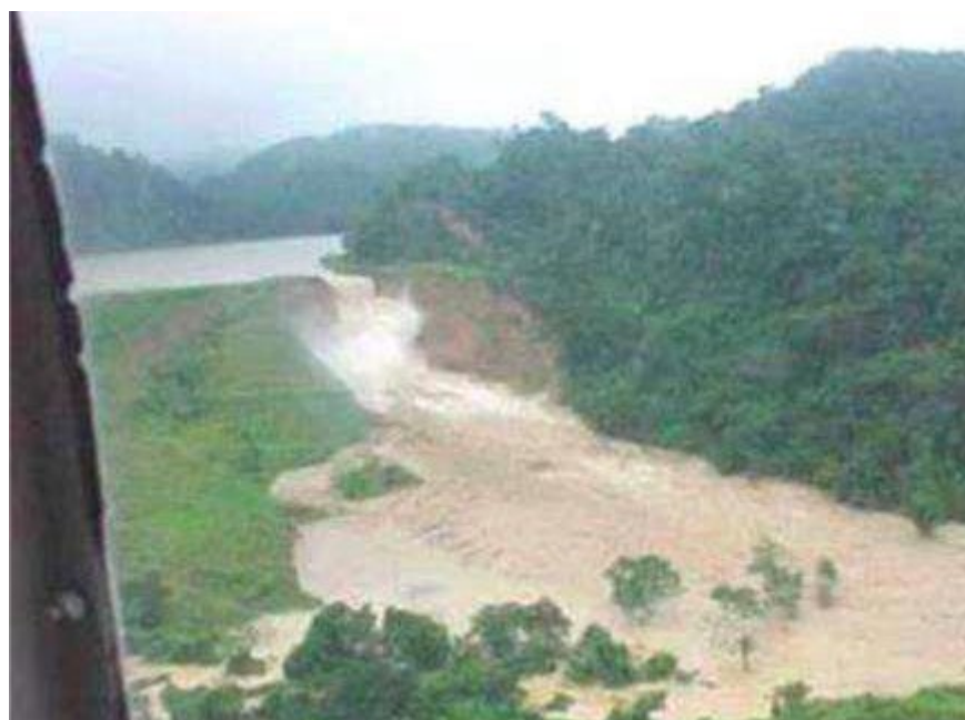
Figura 1 – El Guapo. Ruptura da barragem
