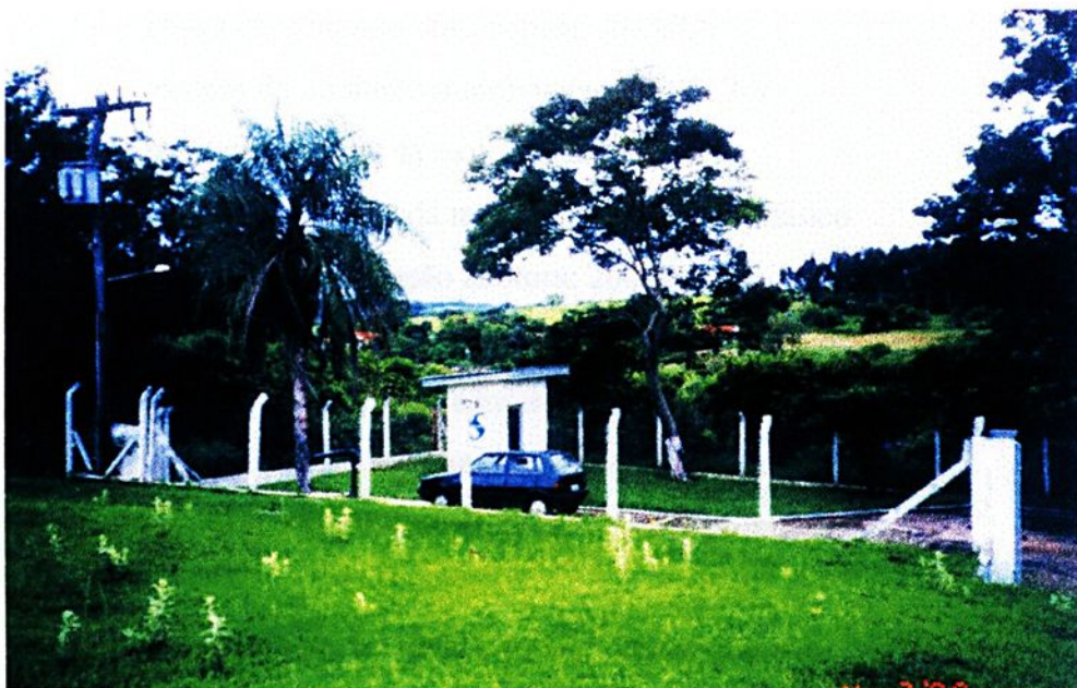
FIGURA 5.1 - Vista geral da área do poço piloto.
