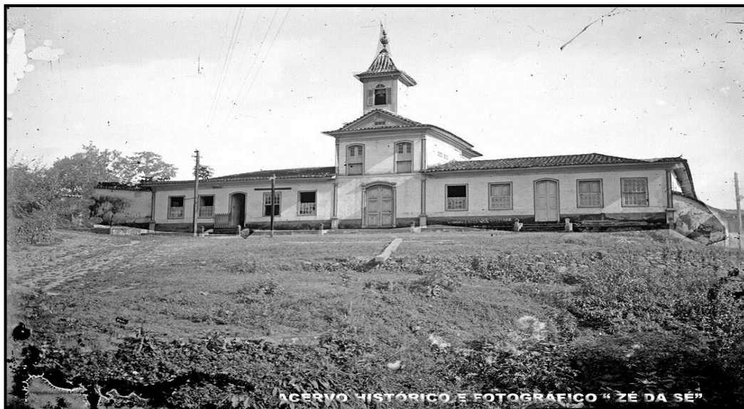
Fotografia 43 – Antiga Capela da Padroeira Santa Isabel na Santa Casa de Caridade.
