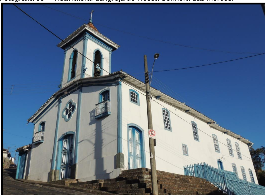
Fotografia 35 – Vista lateral da Igreja de Nossa Senhora das Mercês.
