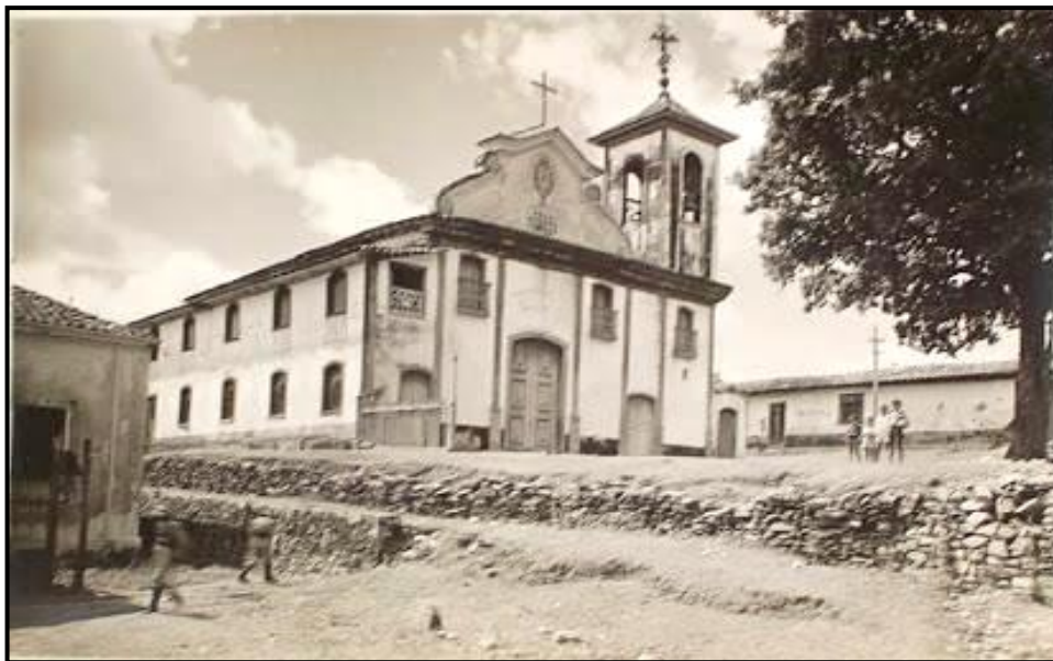
Fotografia 20 – Fachada da Igreja de Nossa Senhora do Rosário.
