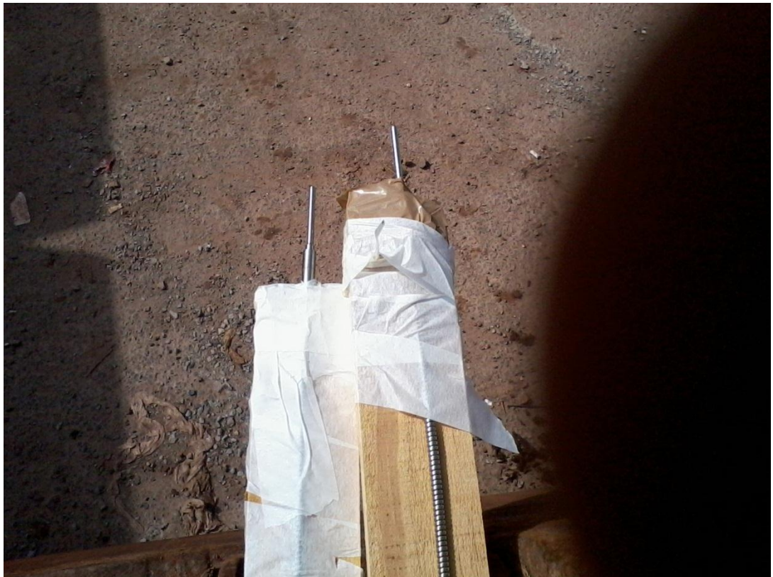
Figura 23: Detalhe da extremidade da termorresistência - sensor instalado fora do suporte das ripas de madeira. Fonte: Autor.
