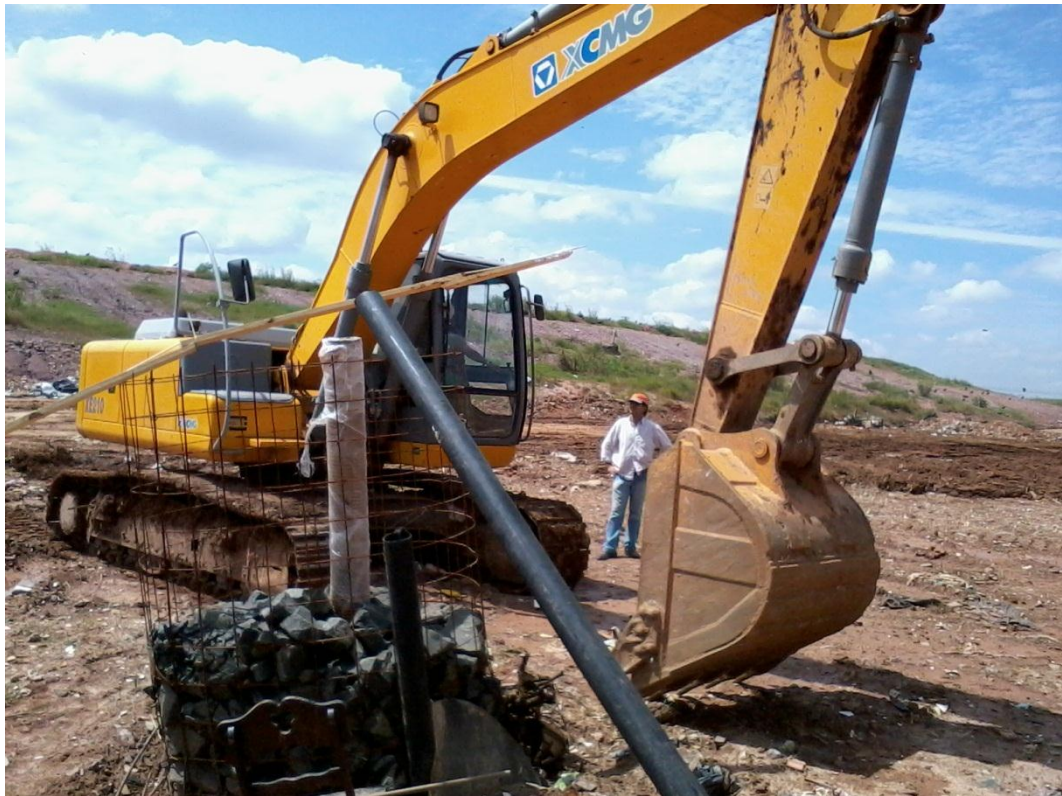
Figura 26: Início da escavação da massa de resíduos ao lado do Dreno 31 para instalação das termorresistências. Fonte: Autor
