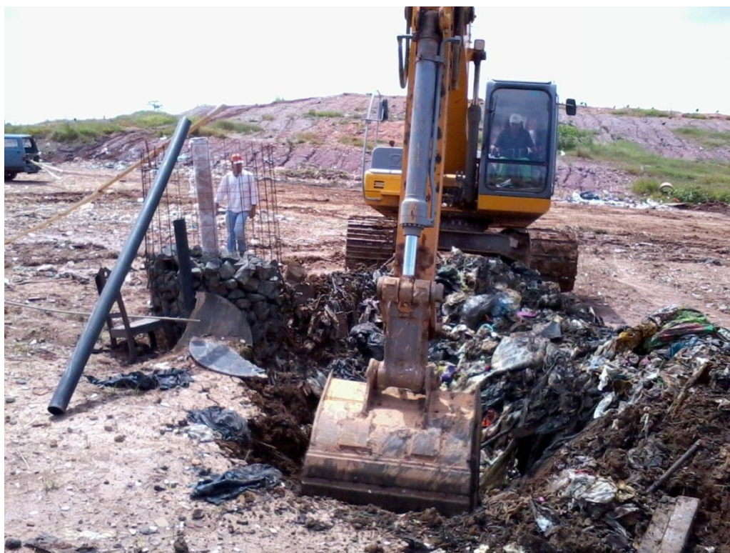
Figura 27: Início da escavação do aterro ao lado do Dreno 32 para a instalação das termorresistências (Ponto “P2”), realizado com a máquina escavadeira “Poclain”. Fonte: Autor.
