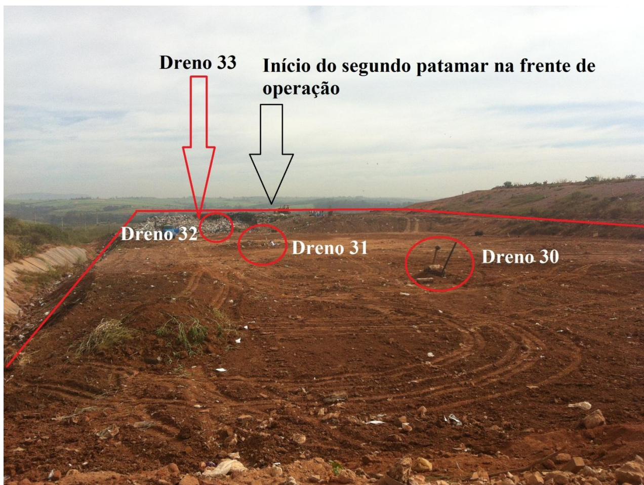
Figura 18: Limites da nova célula de disposição (em vermelho) e localização dos drenos 30, 31, 32 e indicação do dreno 33. Fonte: Autor.
