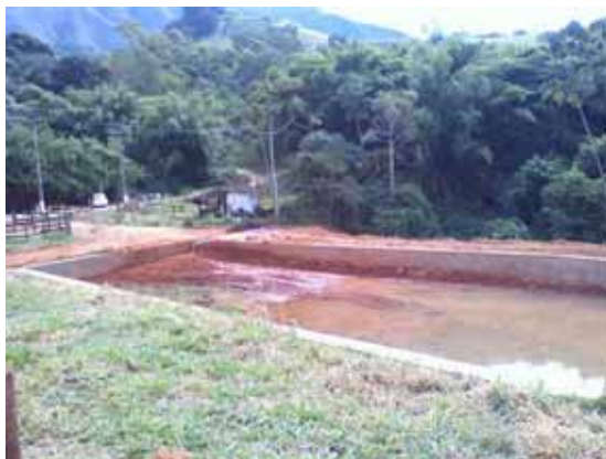
Figura 28 – Lago para Pesca em construção
