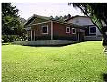
Figura 44 – Vista externa apartamentos 400
