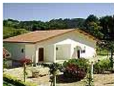
Figura 45 – Vista externa apartamentos 400
