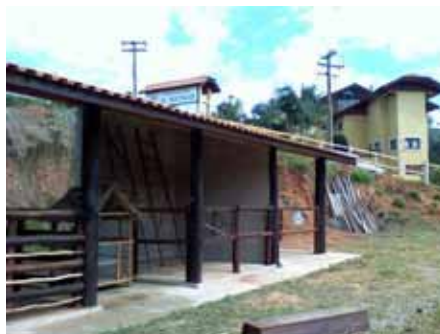
Figura 29 – Área de cocheiras em construção
