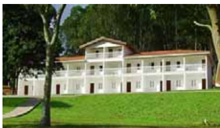
Figura 48 – Vista externa apartamentos 600
