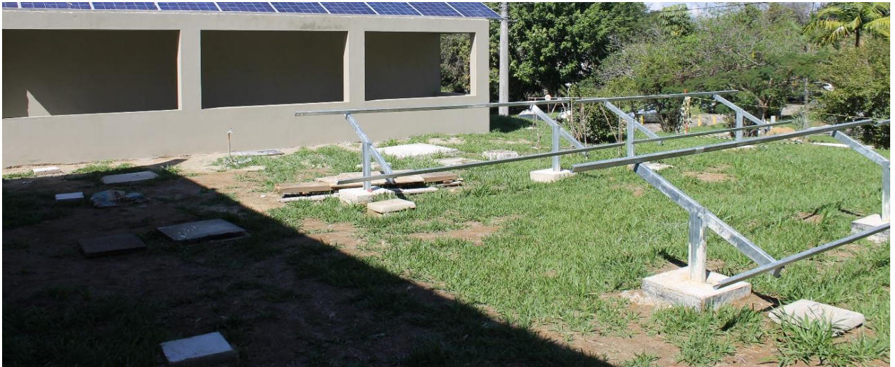
Figura 51 – Áreas de sombra sobre os eletrodutos enterrados.
