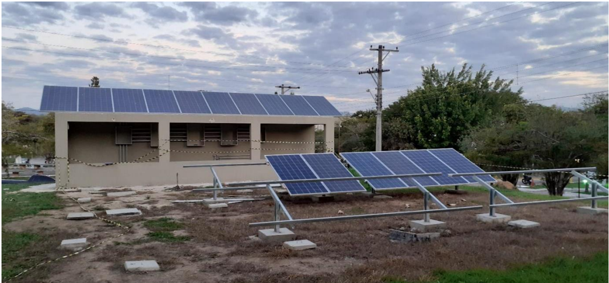
Figura 25 – Estrutura para ampliação.
