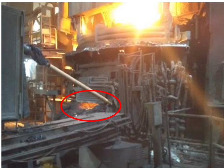
Figura 16 - Entrada de ar falso pela porta de escória.
