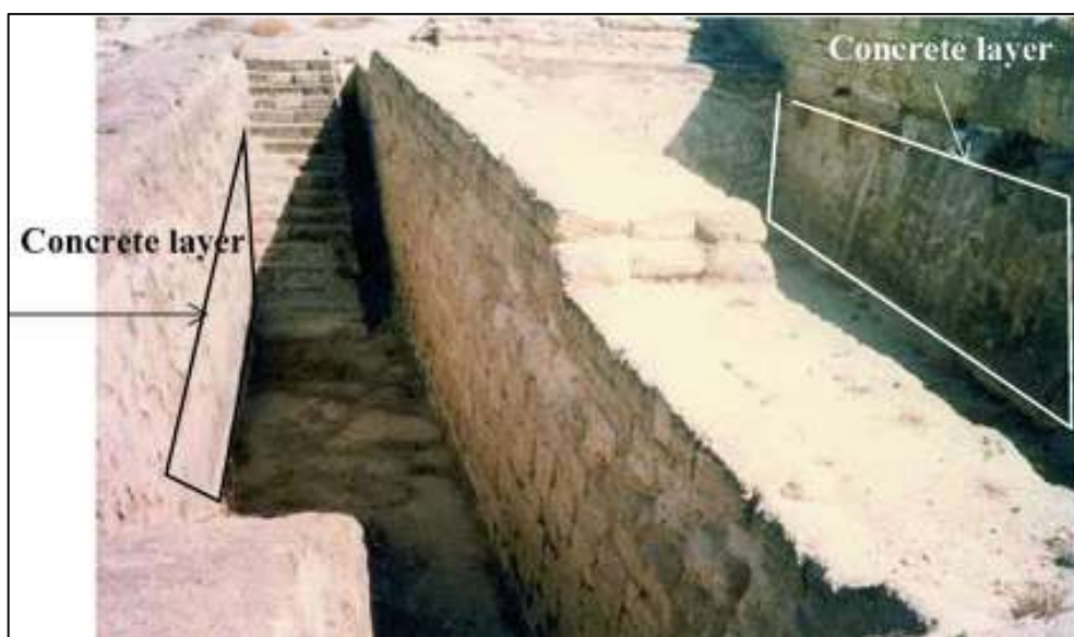
Figura 6 - Reservatório de água na cidade de Camiros, localizada na ilha de Rhodes.
