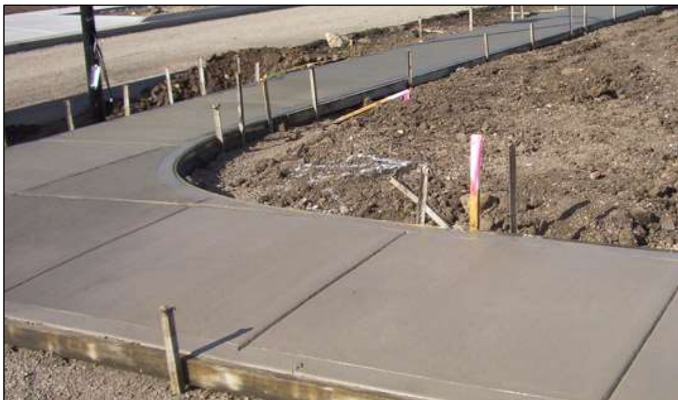
Figura 9 - Calçada feita de concreto de ativação alcalina.
