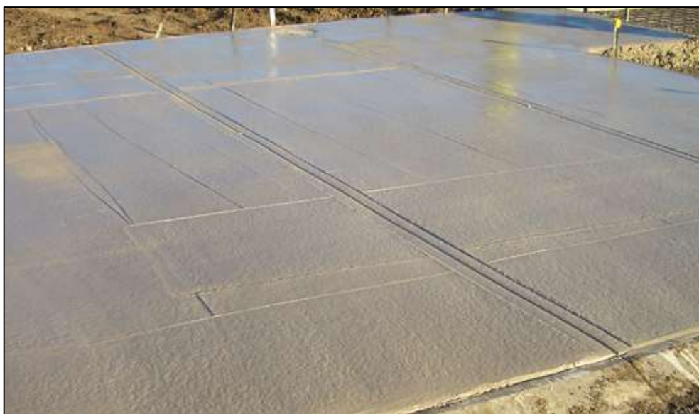
Figura 10 - Laje radier em concreto de ativação alcalina.
