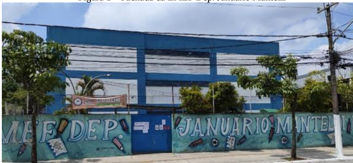
Figura 1 – Fachada da EMEF Dep. Januário Mantelli
