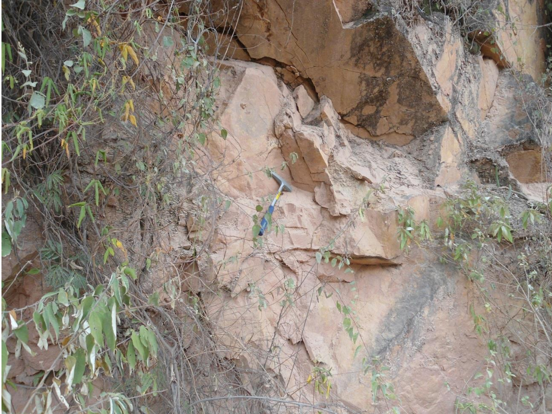
Figura 4.9 – Quartzito do Conglomerado Superior, fraturamento paralelos ao acamamento são observados na foto (vista em perfil, visada para N) – Ponto MVA 13.
