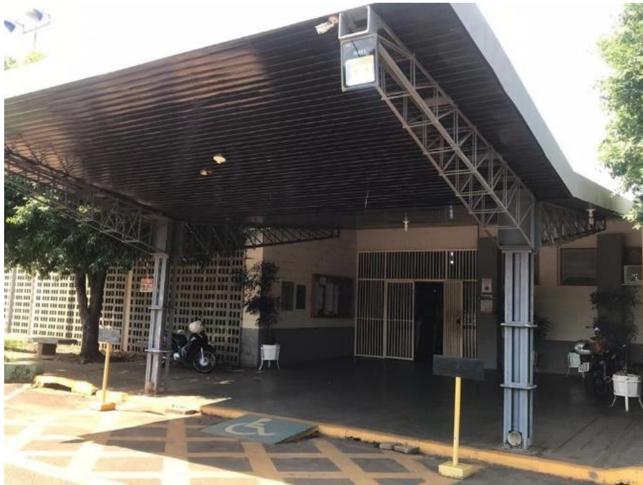
Figura 3 – Etec de Ilha Solteira (vista interna)
