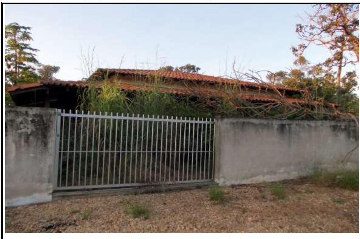
Foto 16 - Casa abandonada. Bairro Portal dos cerrados em 2015
