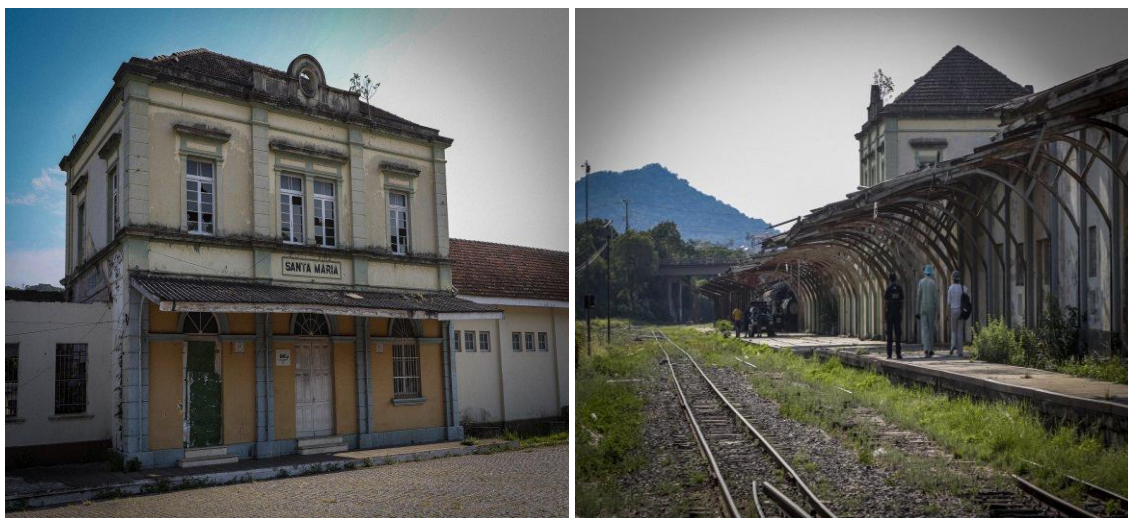
Figura 45: Fotos da Gare da Viação Férrea antes da revitalização
