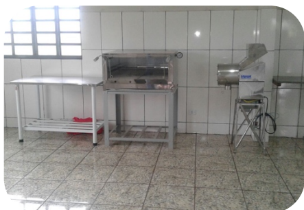
Equipamentos no interior da packing house
