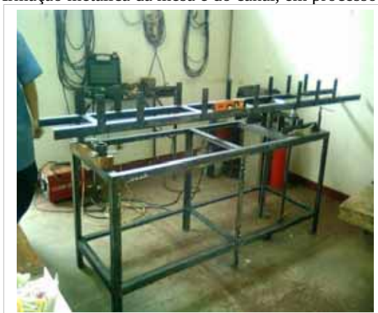
Figura 11 – Armação metálica da mesa e do canal, em processo de construção.
