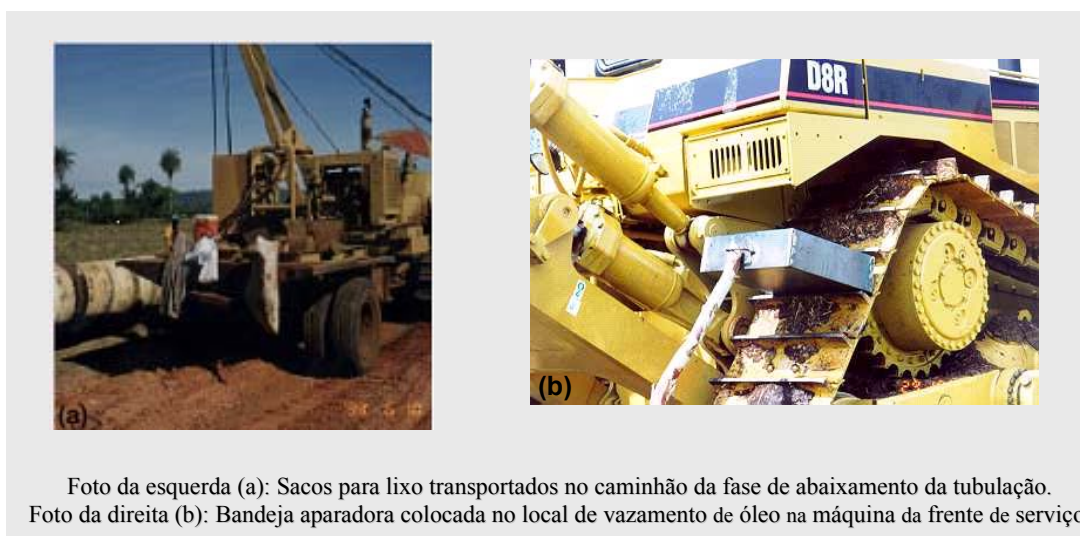
Figura 4.15 – Organização e Limpeza nas Frentes de Serviço de Obra Linear
