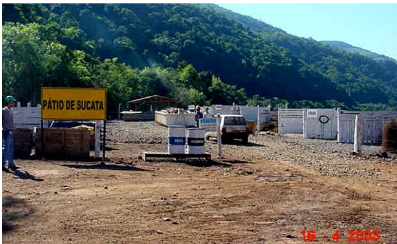
Figura 4.45 – Implantação e Gerenciamento de Pátio de Sucatas na Obra
