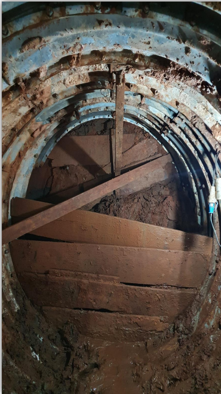
Figura 7.2 – Condição geotécnica do maciço na região da frente de escavação
