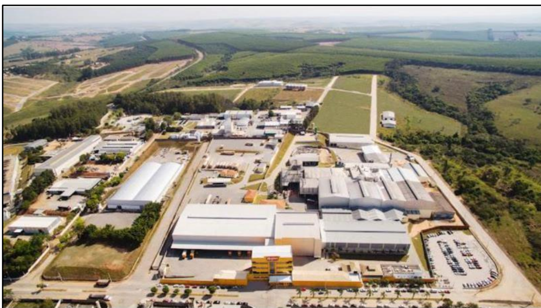
Figura 1. Vista aérea da unidade fabril de Salto de Pirapora. Fonte: adimax.com.br.
