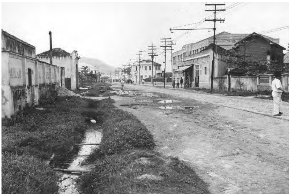
Fig. 6.2- Bairro Estuário após a chuva. Imagem da Rua Senador Dantas. À esquerda, estão as valas para escoamento da enxurrada. À direita, a rua em terra e areião, e mais à direita, um senhor está sobre o calçamento do bonde. Acima, o Grupo Escolar Municipal “Cidade de Santos”, com algumas pessoas à frente. Muitos alunos que ingressaram no Ginásio do Maracanãzinho eram provenientes desta escola. Destaca-se na fotografia, as condições de insalubridade do bairro, devido ao acúmulo de água nas valas, com a conseqüente proliferação de pragas, final da década de 1960. Foto de autoria desconhecida. (Fonte: Acervo do FAMS, Santos, SP).
