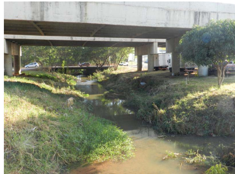
Figura 18 – rodovia passando sobre o córrego dos Macacos
