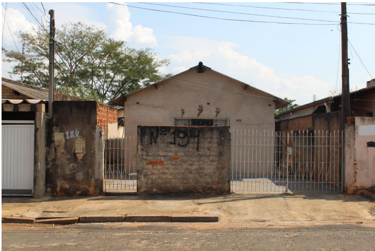
Figura 19: Mutirão Carmem Carrijo Coube - Casa com fachada reformada e rebocada e telhado original
