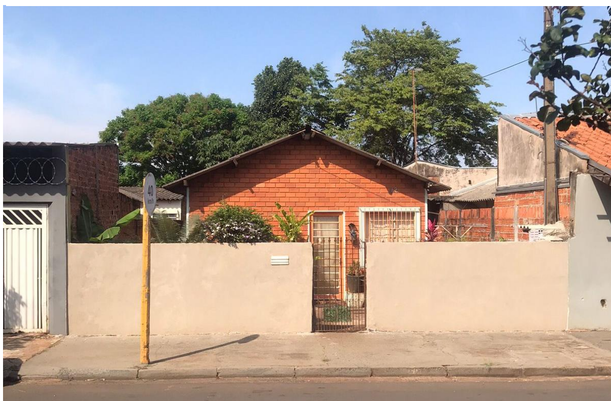
Figura 18: Mutirão Carmem Carrijo Coube - Casa com fachada e telhado originais
