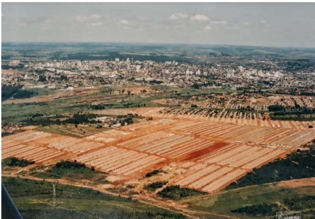
Figura 5: O Conjunto Habitacional Mary Dota em fase de construção
