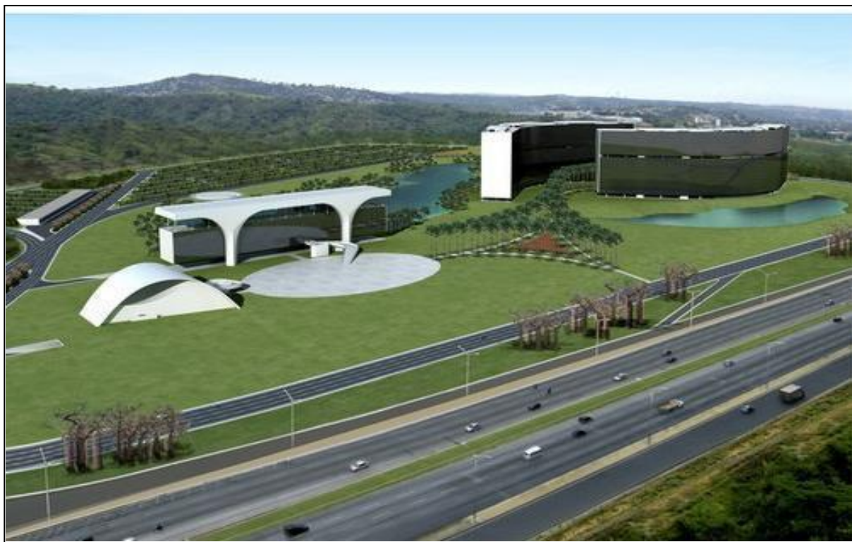
Figura 7 - Cidade Administrativa Presidente Tancredo Neves, em Belo Horizonte (Reitoria da UEMG)
