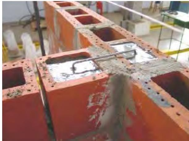
Figura 18 - Detalhe de amarração indireta com grampo metálico, (SILVA, 2003, p. 63).
