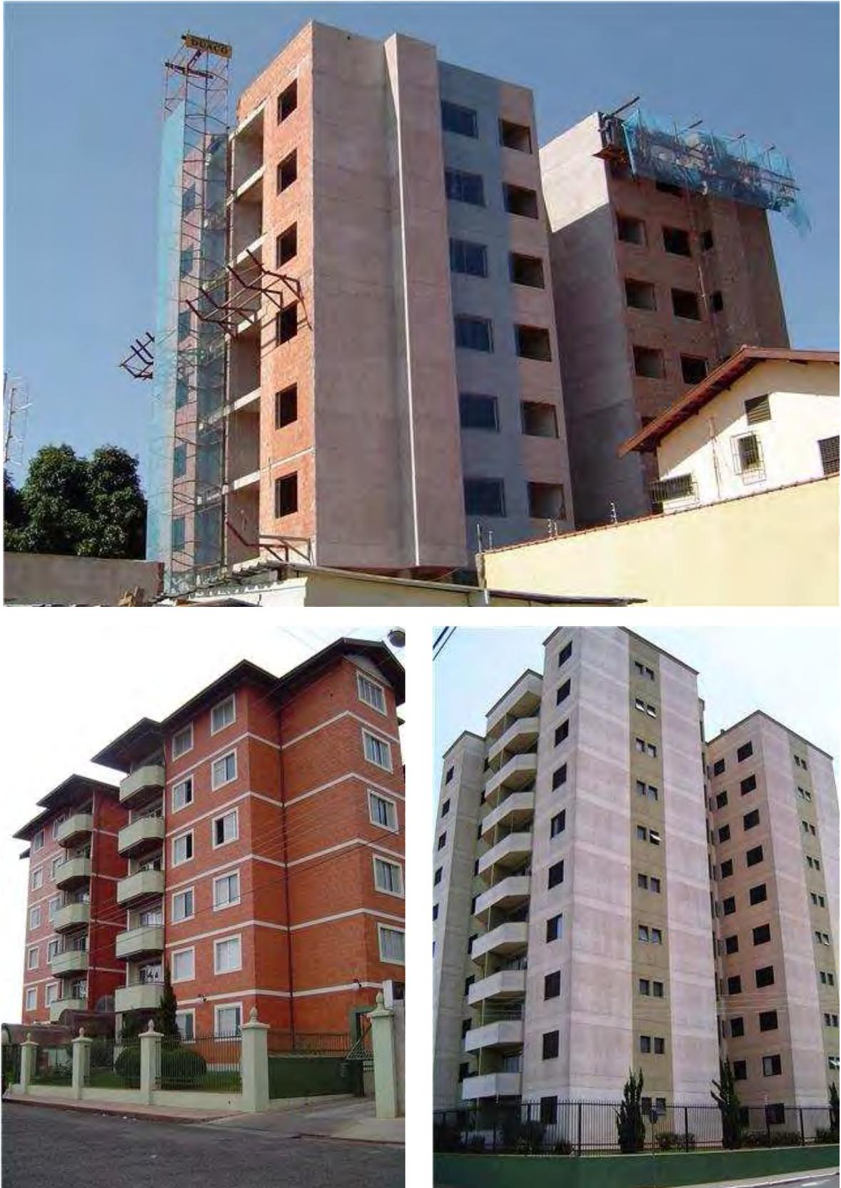
Figura 9 - Edifícios em alvenaria estrutural de blocos cerâmicos. Fonte: Cerâmica Selecta.
