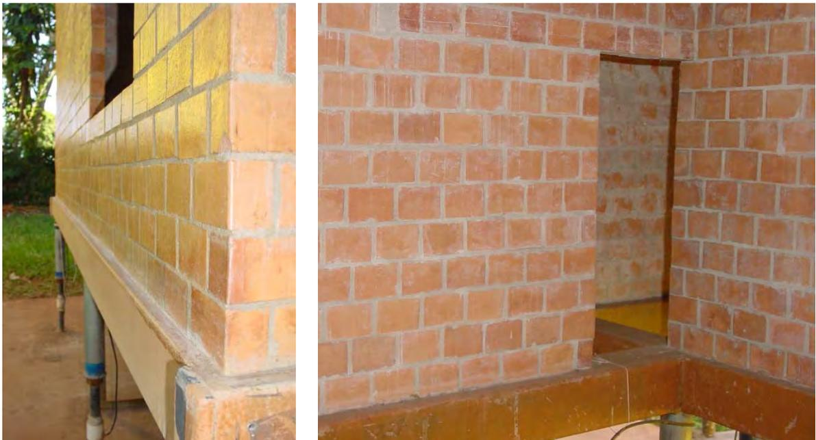
Figura 53 - Detalhes do assentamento das paredes do térreo sobre a viga metálica.
