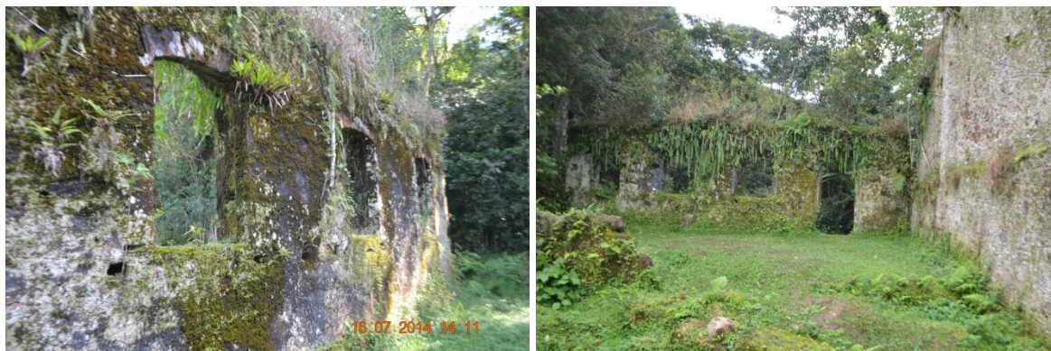
Figura 12 - Ruína ou Casa de Pedra 5
