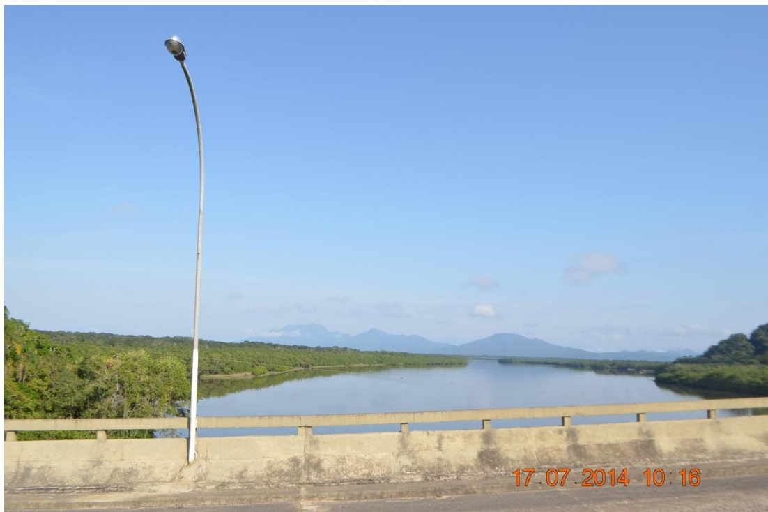
Figura 14 - Lagamar, foto tirada da ponte que liga o continente à ilha de Cananéia
