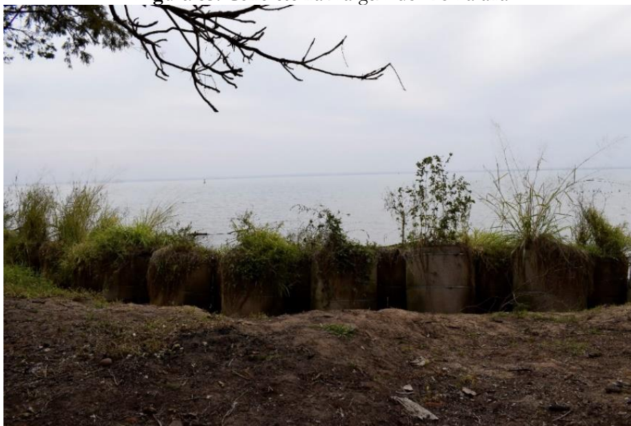
Figura 83: Concreto na margem do Rio Paraná
