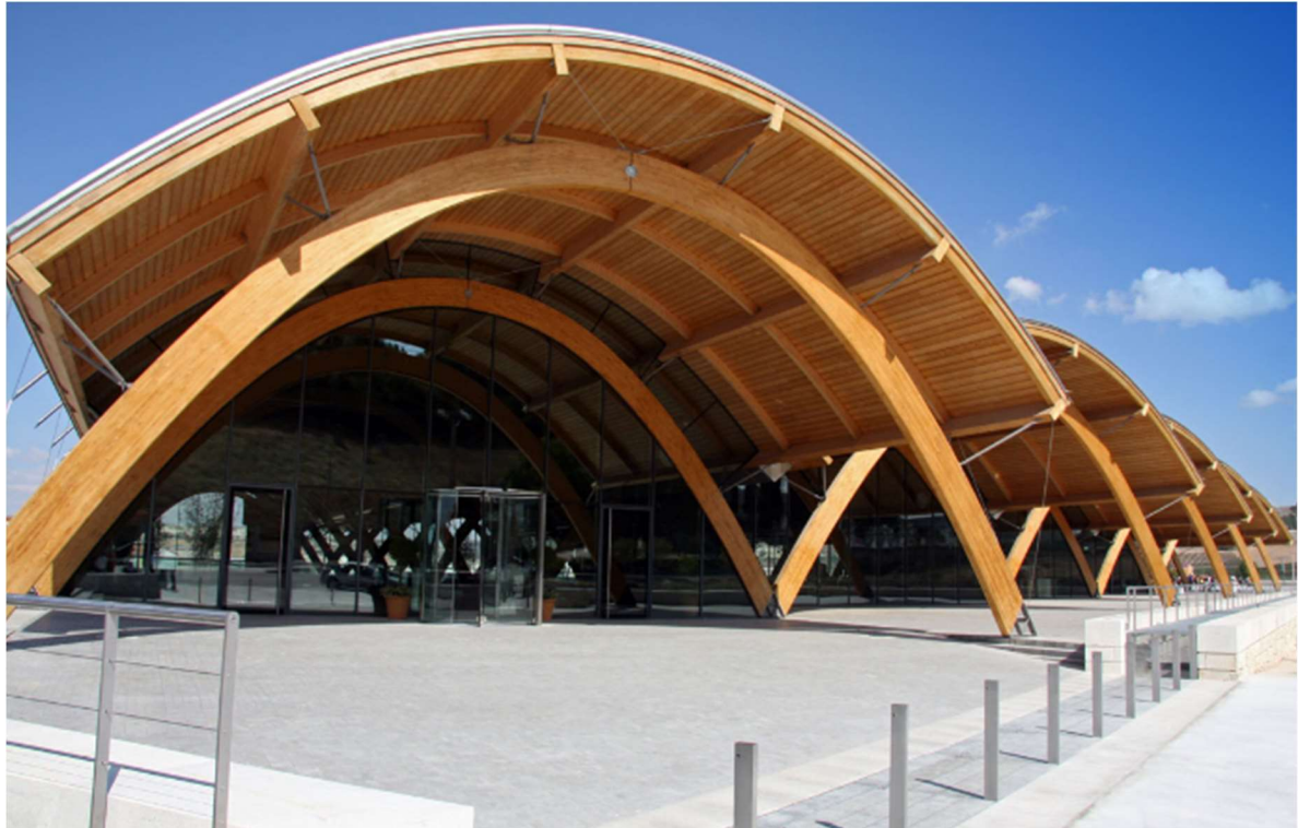
(a) Estrutura de cobertura em arco
