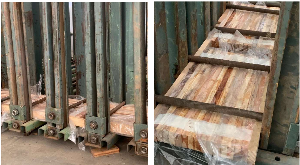
Figura 32 – Prensagem das vigas em prensa industrial.
