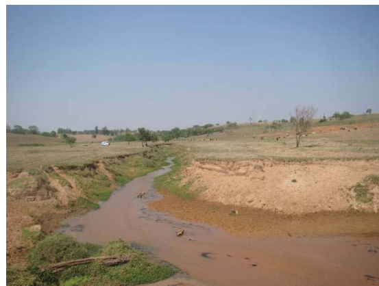
Figura 17 – Trecho após foz do córrego do Embirí; ambos casos cursos d'água assoreados e com ausência total de mata ciliar.
