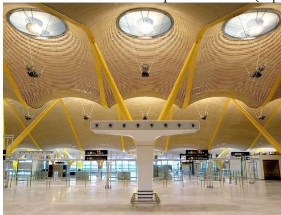
Figura 17: Teto de bambu do aeroporto de Madrid (Espanha)
