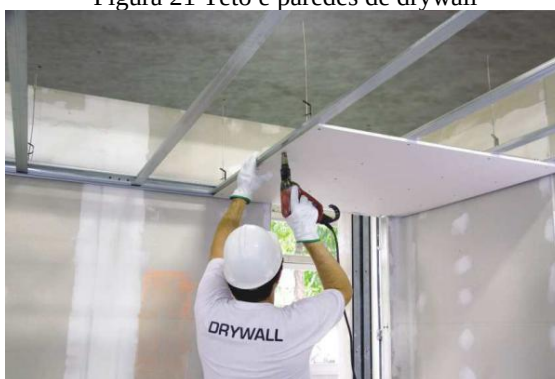
Figura 21 Teto e paredes de drywall
