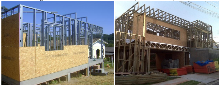
Figura 22: Casas construídas com Steel frame e Wood frame
