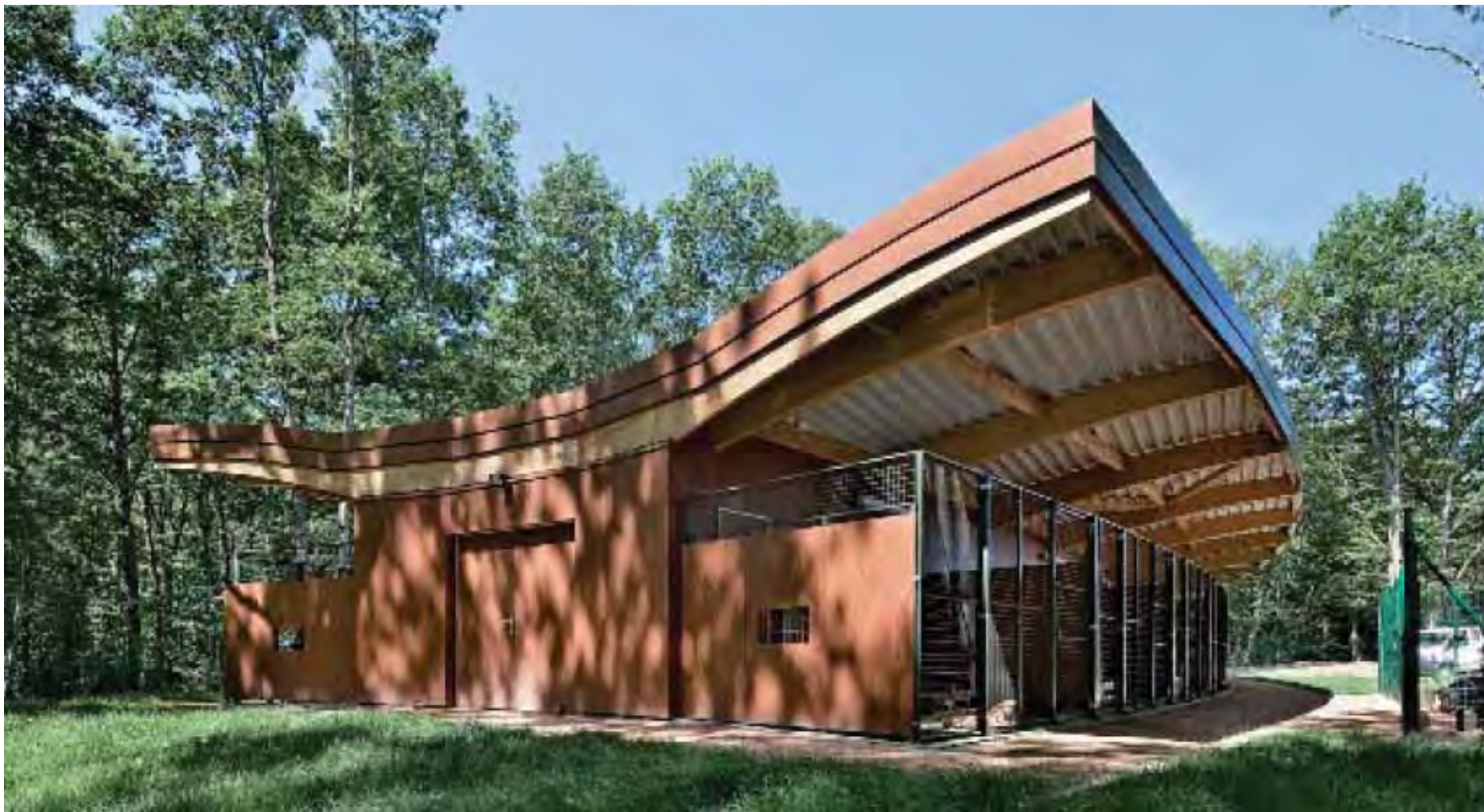
Figura 14: Vista de um dos pavilhões.
