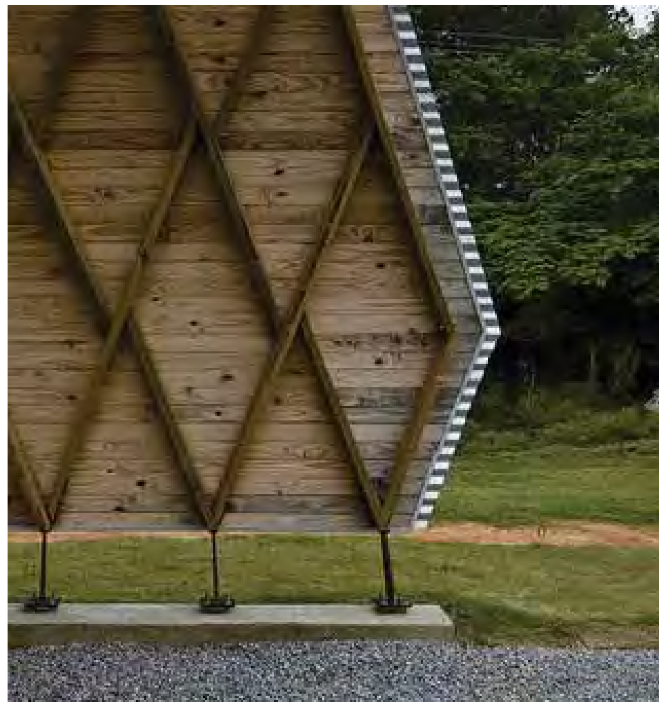
Figura 9: Detalhe da estrutura modular em madeira laminada.
