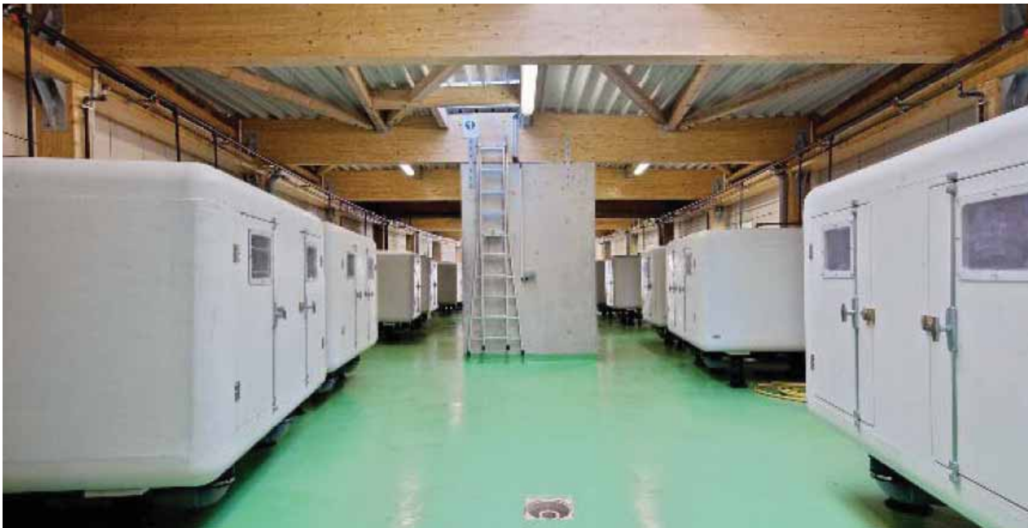
Figura 16: Vista do corredor de serviços, detalhe às “caixas”.
