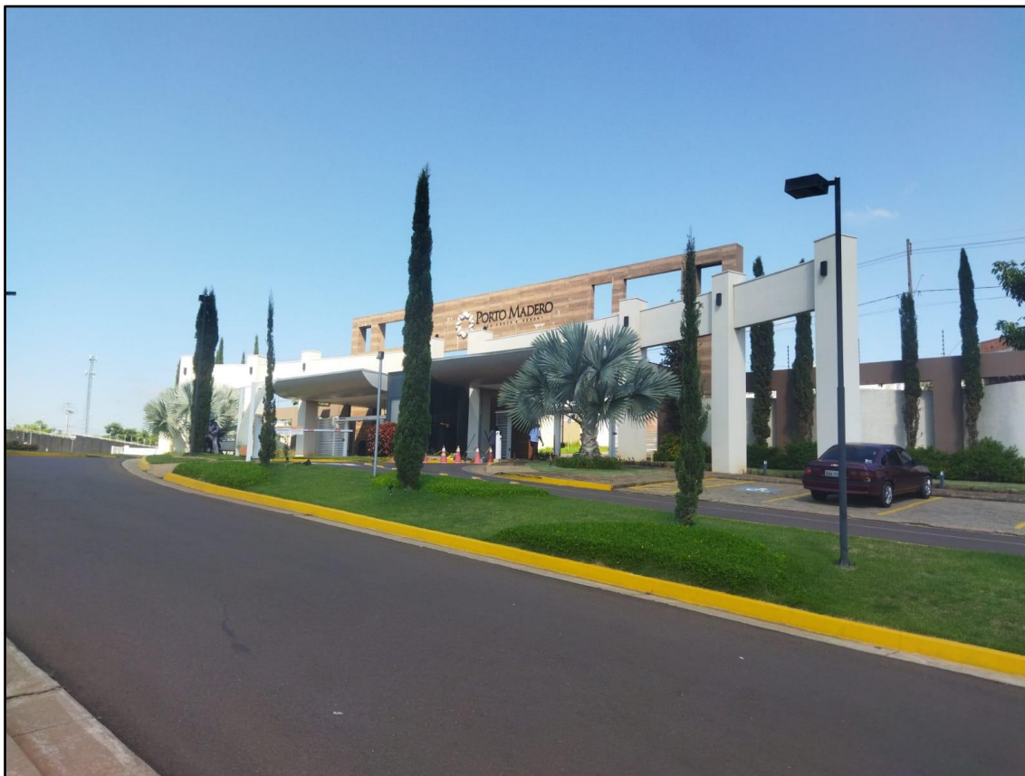
Figura 24 – Portaria do Porto Madero
