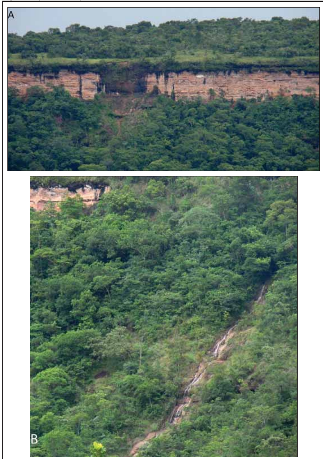
Figura 19 – A: front da escarpa com detalhe para cicatriz de movimento de massa com mobilização de blocos rochosos e solo saprolítico, visualizado no ponto 12; B: escoamento superficial concentrado caracterizado por cursos d'água intermitentes e cachoeiras, registrado próximo ao ponto 12
