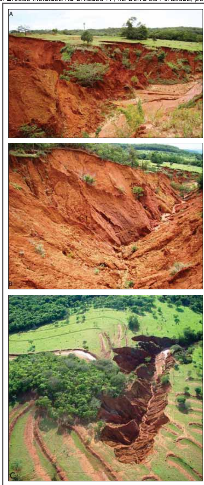
Figura 20 - A/B: interior da voçoroca (de diferentes ângulos); C: vista aérea da voçoroca. Erosão instalada na Unidade IV, na Serra da Fortaleza, ponto 10
