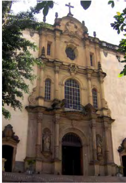
Figura 38. Detalhe da fachada da Igreja do Carmo da Rua Martiniano de Carvalho
