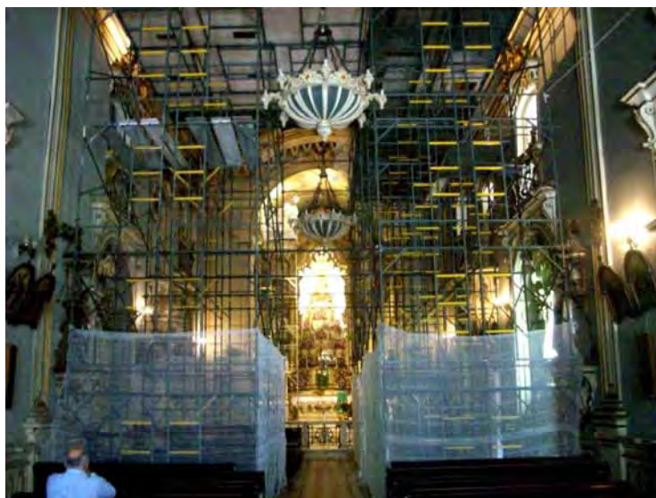
Figura 140. Andaimos instalados na nave da Igreja do Carmo para execução dos serviços de restauro do painel central, 2008.
