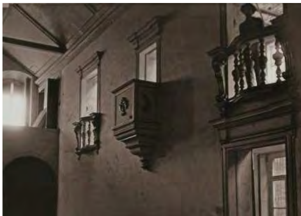
Figura 45. Interior da capela do Recolhimento de Santa Teresa pouco antes da demolição. Fotografia de Aurélio Becherini. Sem data.
