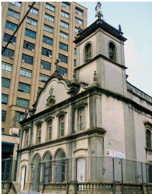
Figura 59. Fachada frontal da Igreja do Carmo. Outubro de 2008.
