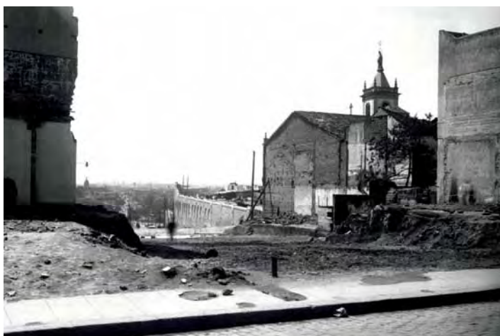
Figura 53. Demolição do Convento e Igreja do Carmo, em foto de Becherini, 1934.
