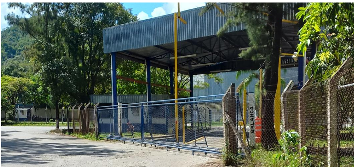
Figura 1 – Grades e muros no porto seco de Juiz de Fora. Fonte: A autora (2022).
