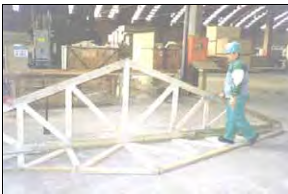
Figura 2 – Aplicação industrial do conector CDE em estruturas de madeira
