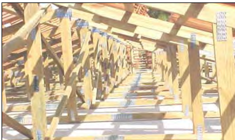
Figura 13 – Estruturas de cobertura produzidas industrialmente com o uso de CDE
