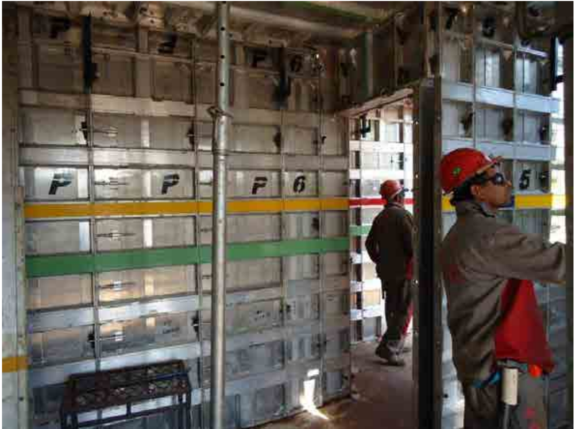
Figura 29 - Forma pronta para ser concretada Fonte: Autor
