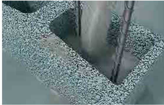
Figura 42 - Aplicação de groute
