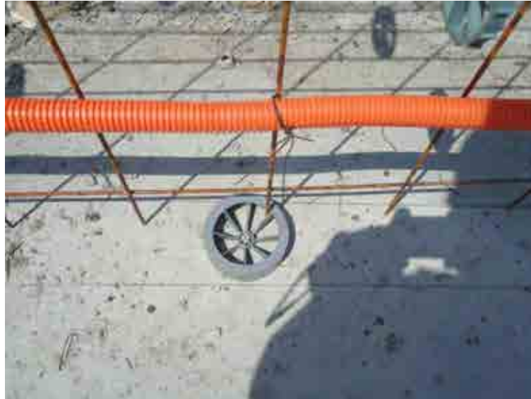
Figura 26 - Espaçador plástico Fonte: Autor
