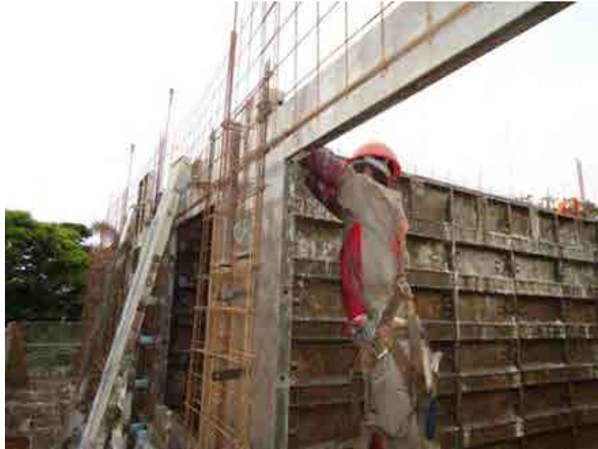
Figura 4 - Montador fazendo os fechamentos das formas Fonte: Autor
