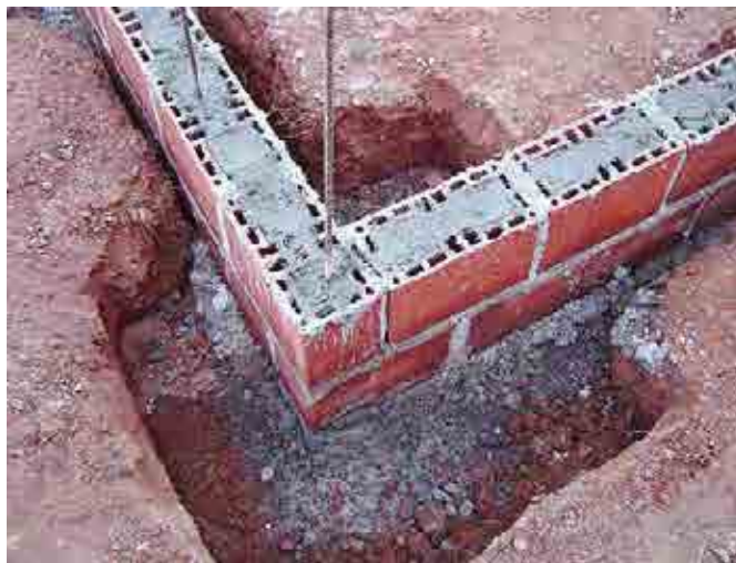
Figura 43 - Alvenaria estrutural já com o groute aplicado
