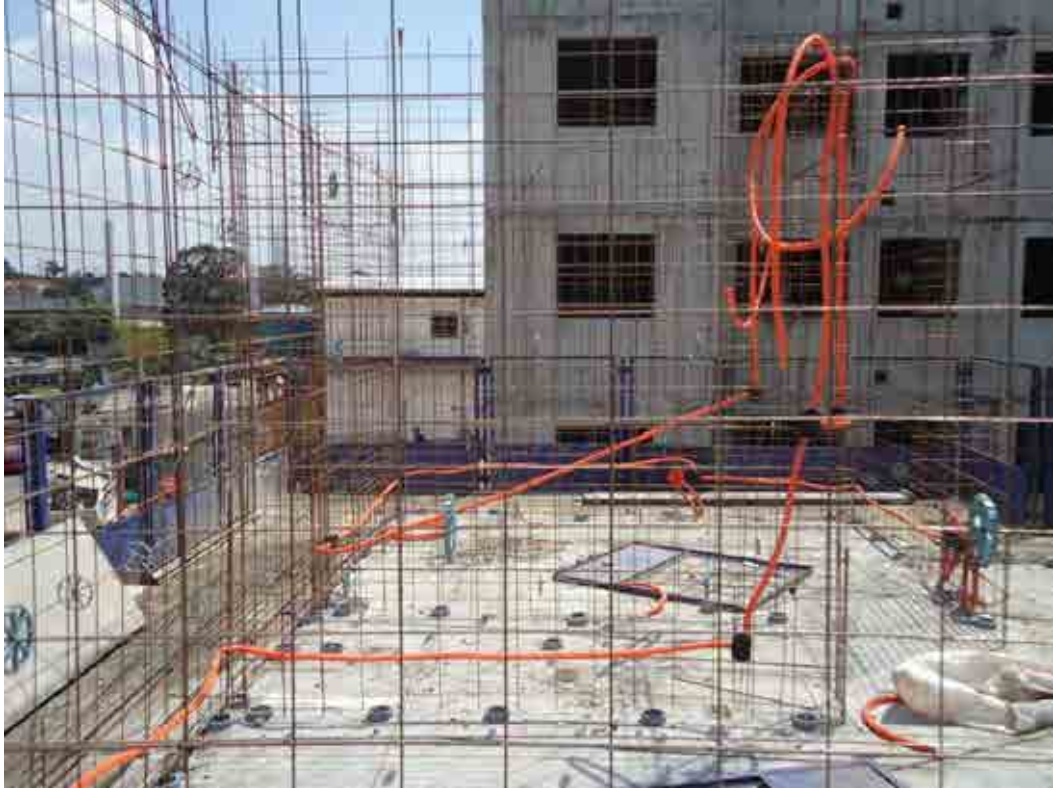
Figura 28 - Armação das paredes
