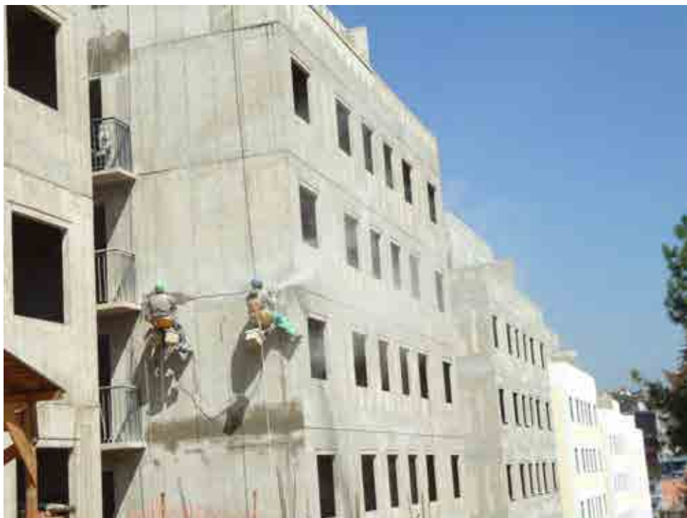
Figura 7 - Estucagem da fachada Fonte: Autor
