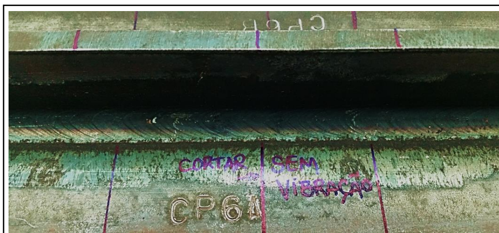
Figura 105 - Cordão de solda CP6: Soldagem sem vibração
