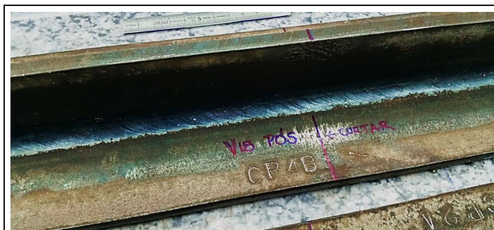
Figura 104 - Cordão de solda CP4: Soldagem com vibração após a realização do cordão
