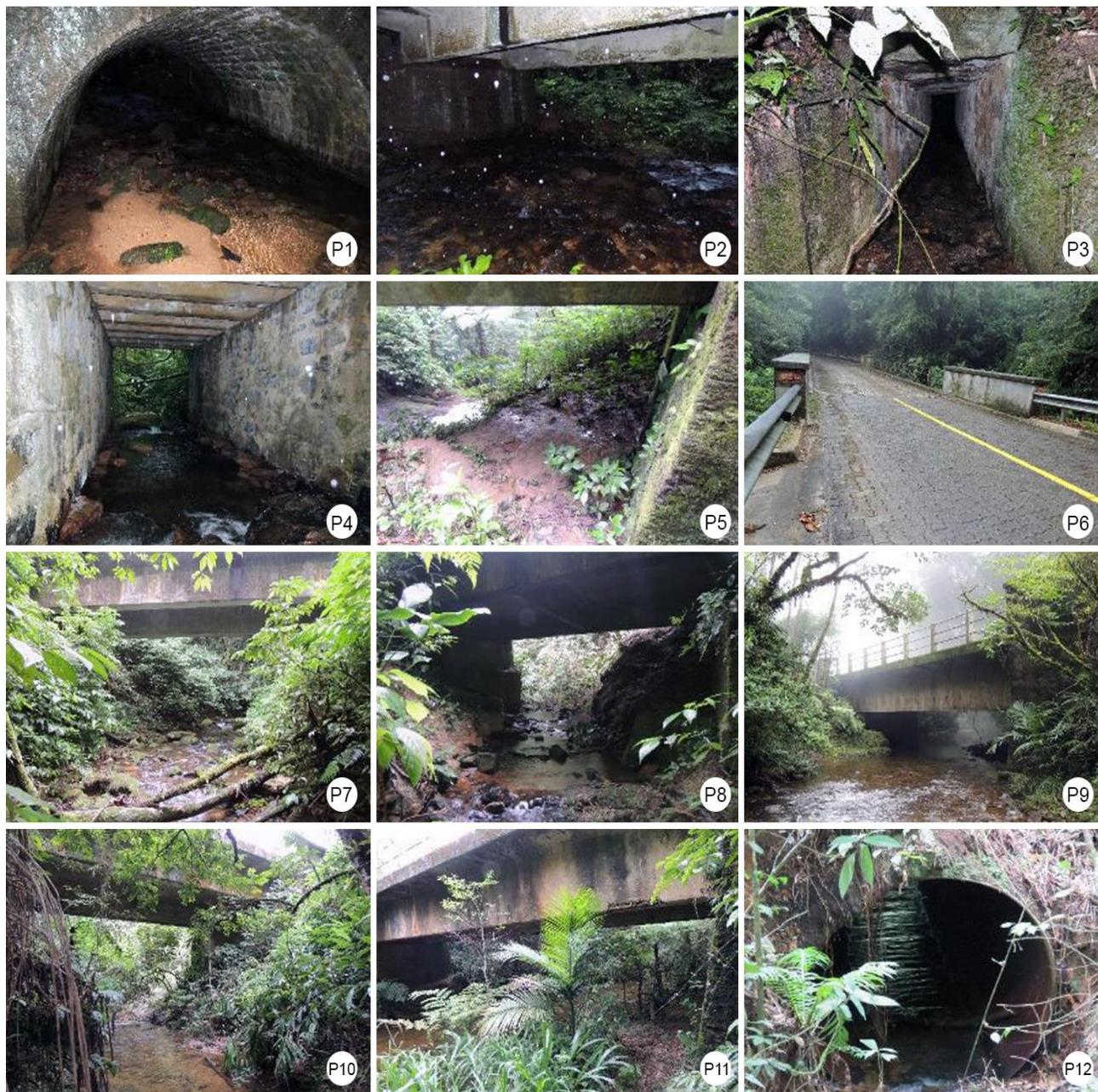
**FIGURA 12.** Passagens inferiores de fauna existentes ao longo da Estrada Parque (SP-139). P1 – galleria circular (Km 46+800), P2 – ponte (Km 56+200), P3 – galleria retangular (Km 56+620), P4 – galleria retangular (Km 58+714), P5 – ponte (km 60+300), P6 – ponte (Km 61+300), P7 – ponte (Km 64+660), P8 – ponte (Km 67+100), P9 – ponte (Km 69+710), P10 – ponte (Km 73+850), P11 – ponte (Km 76+200) e P12 – galleria circular (Km 76+860).
