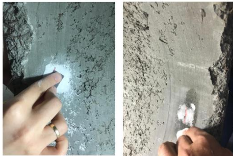
Figura 11 - Preparação final das regiões onde os extensômetros foram colados
