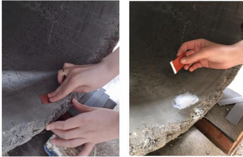
Figura 10 - Preparação inicial das regiões onde os extensômetros foram colados
